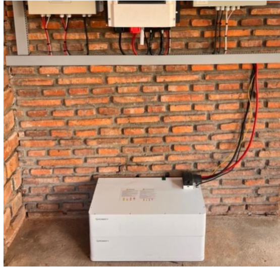
Ilustración 23 Instalación de baterías
