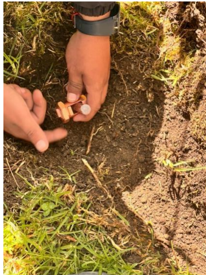
Ilustración 28 Instalación de varilla de cobre bajo tierra
