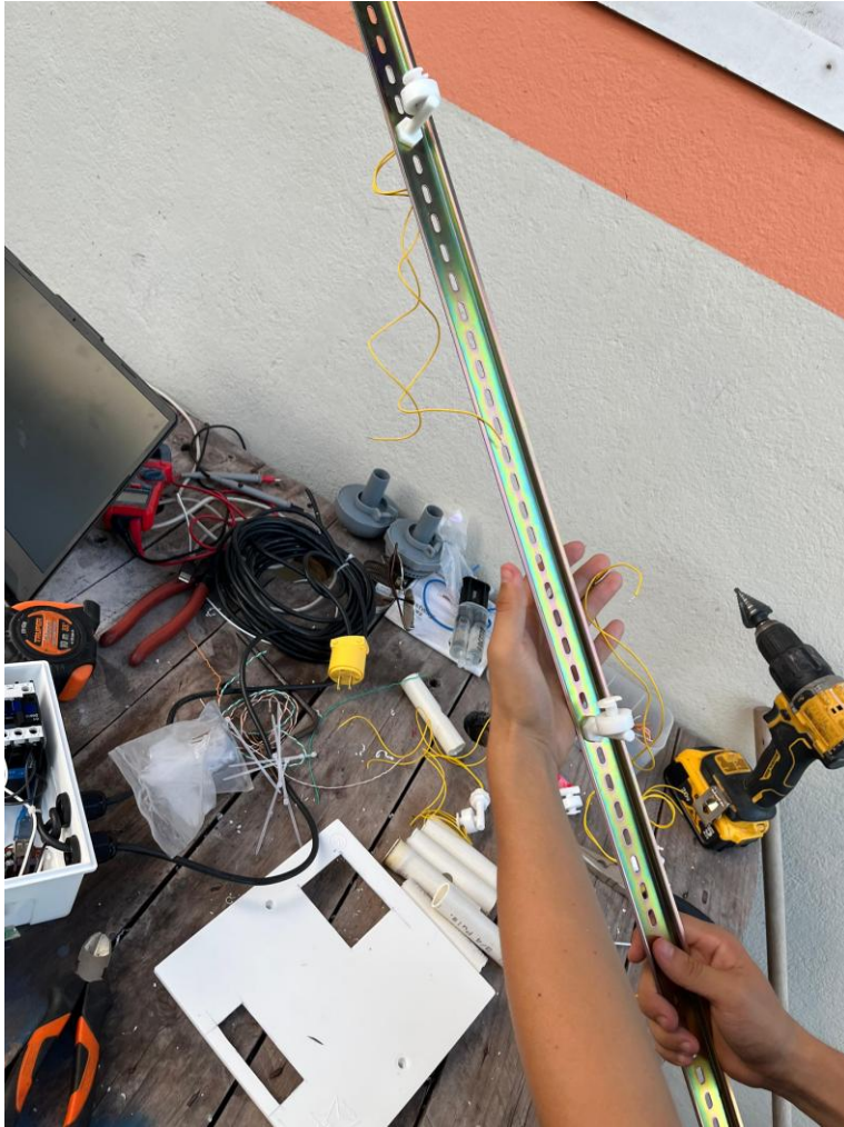
Figura 16 Disposición de los sensores en el anclaje sumergible
