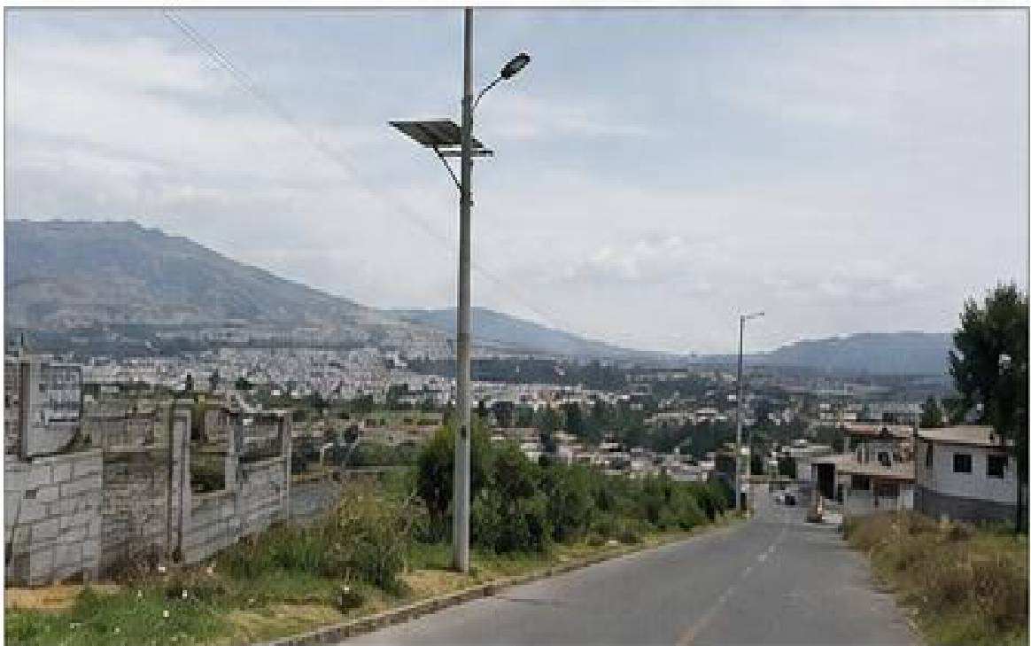
Vista del lugar de instalación
