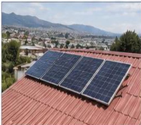
Instalación de paneles solares
