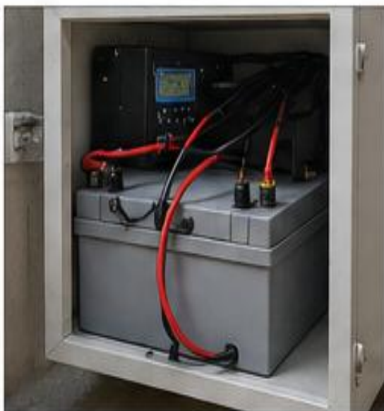
Batería de litio 12 V - 150 Ah
