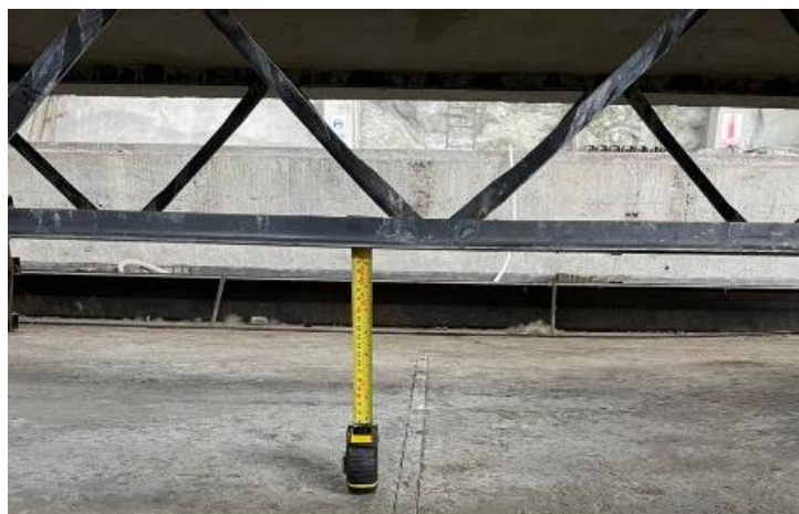
Figura 4-33: Deformación de la estructura en el ensayo 2
