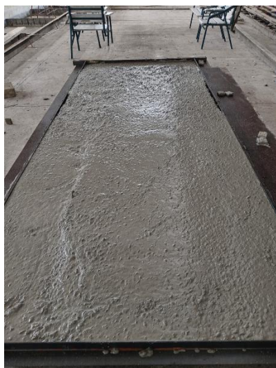
Figura 4-14: Fundición de losa
