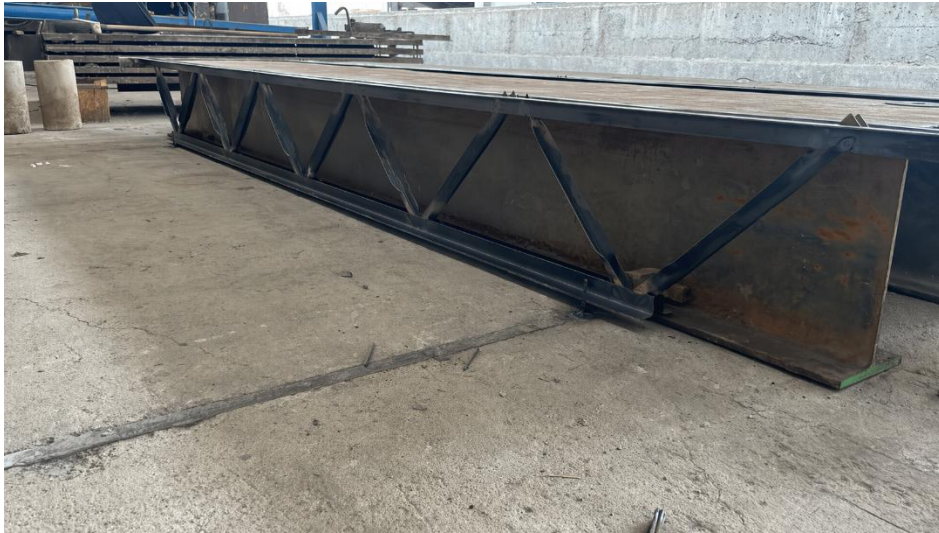
Figura 4-2: Ensamblaje de la viga en celosía
