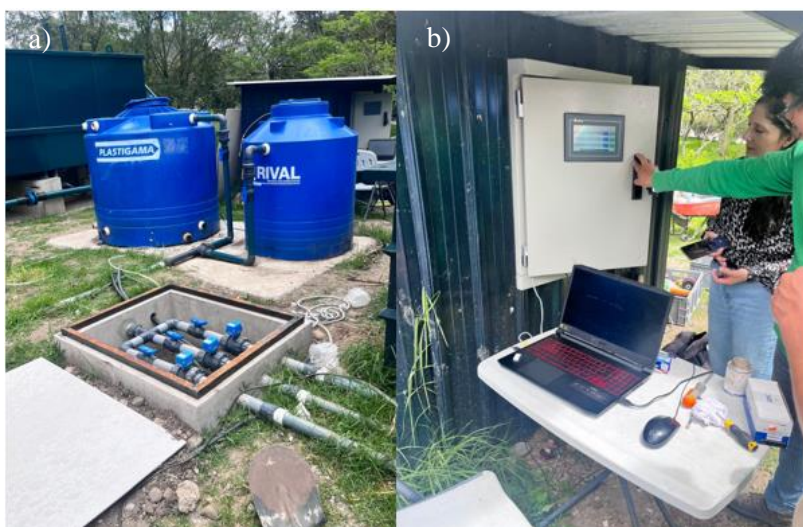
Figura 4. Sistema de alimentación de los humedales construidos: a) Tanques y electroválvulas; b) Sistema de control automatizado.
