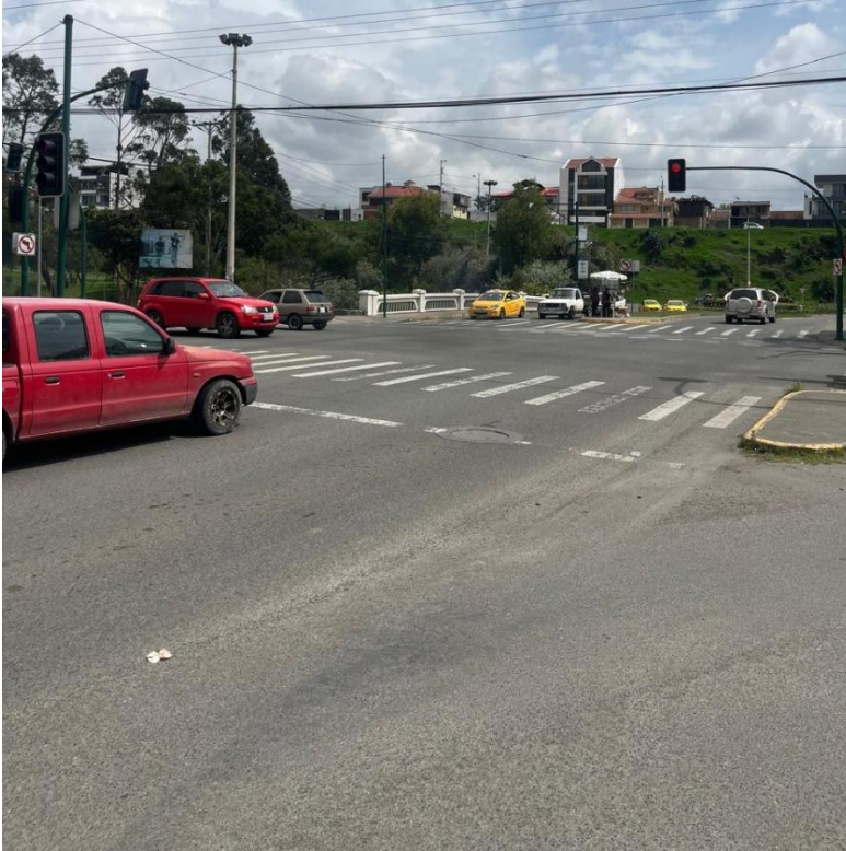
Figura 4-8 Señalización horizontal deficiente Acceso 1
