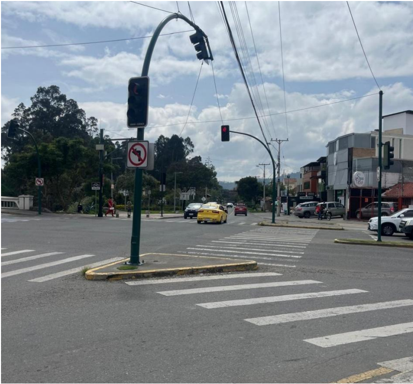
Figura 2-13 Isleta canalizadora acceso 4
