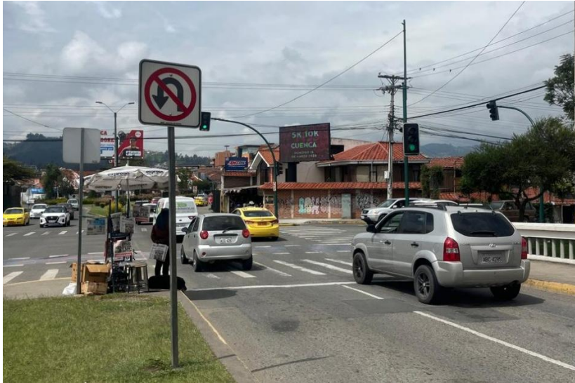
Figura 2-9 Señalización vertical acceso 3
