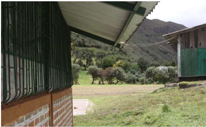
Figura 34. Cámara 5 - Pasillo Escuela. Nota. Elaboración propia, 2025.
