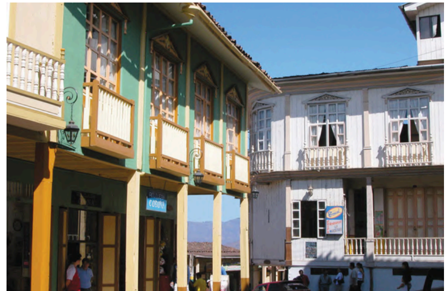
Imagen 3. Imagen referencial de las estructuras de las casas patrimoniales de Zaruma
