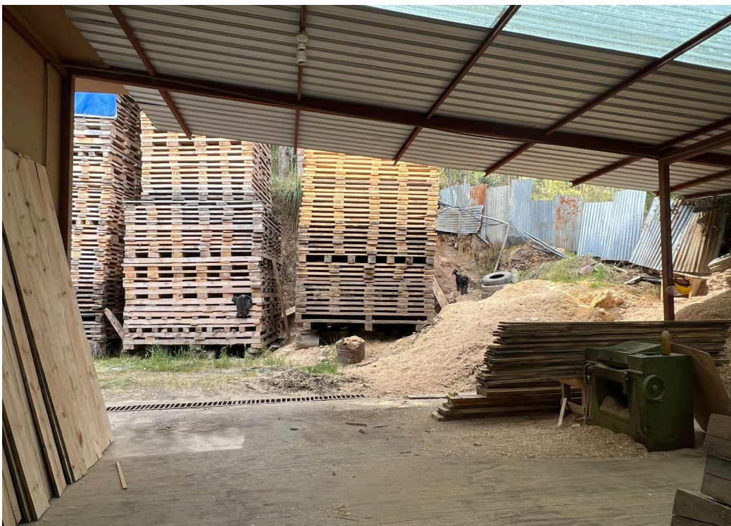
Nota. Vista frontal de la fábrica el pino. Elaboración propia (2026).
