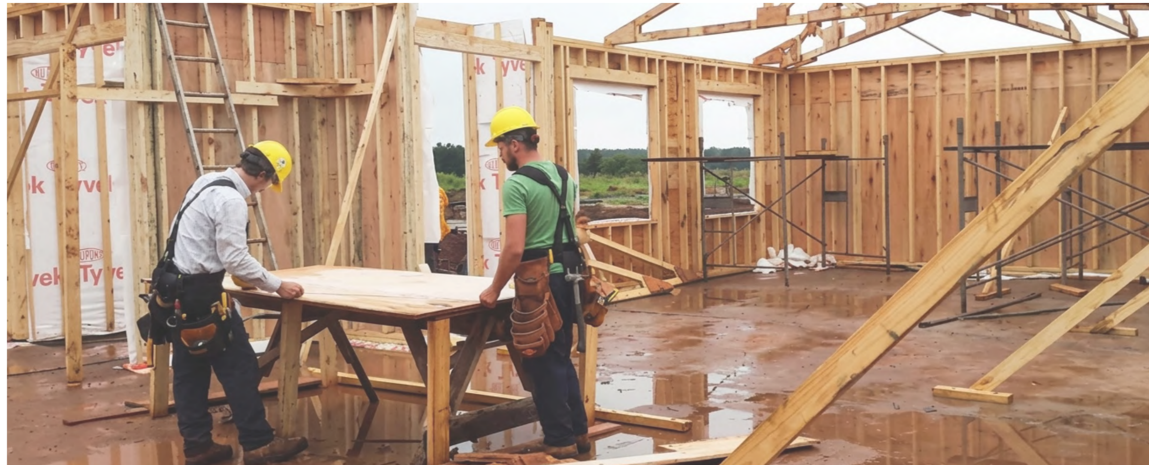
Figura No. 7. Construcción en seco. Nota. Adaptado de La construcción con madera permite bajar costos, los plazos de la obra se acortan y se cumplen de forma estricta. Y la aislación térmica es entre 7 y 14 veces más efectiva que la que aportan materiales convencionales [Fotografía], por J. L. Cieri, 2021, Infobae.
