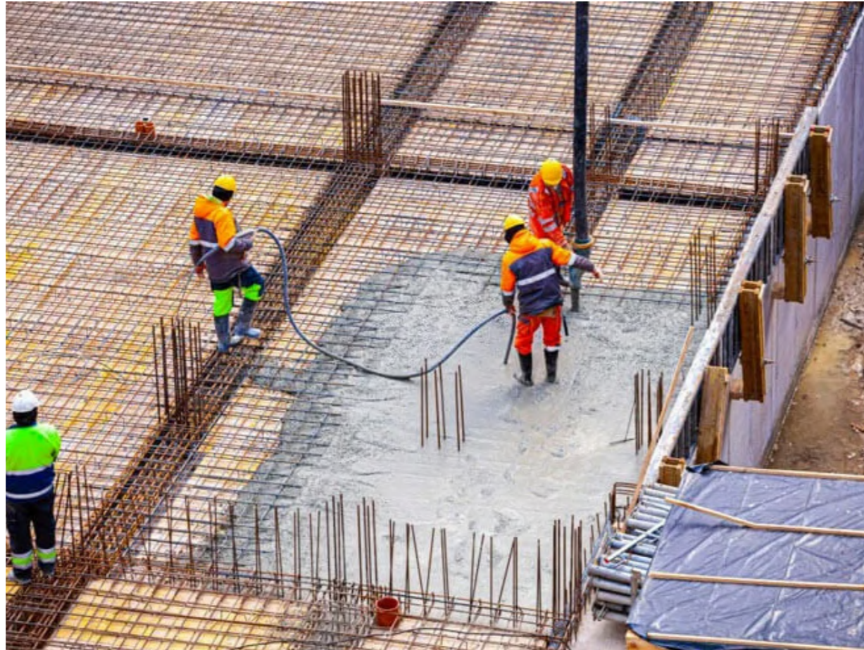
Figura No. 2. Proceso de encofrado y apuntalamiento de losa tradicional. Nota. Adaptado de Guía de construcción: Losa de concreto [Fotografía], por Cemex, 2021, Cemex
