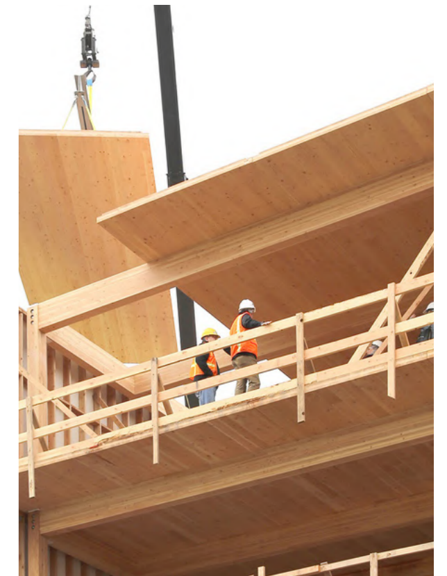
Figura No. 61. Prefabricación con paneles CLT. Nota. Obtenido de Montaje de estructura en madera contralaminada (CLT) [Imagen], por LEVER Architecture, 2023, ArchDaily en Español ( https://www.archdaily.cl/cl/997631/50-proyectos-que-muestran-el-auge-de-la-construccion-de-madera-contralaminada ).
