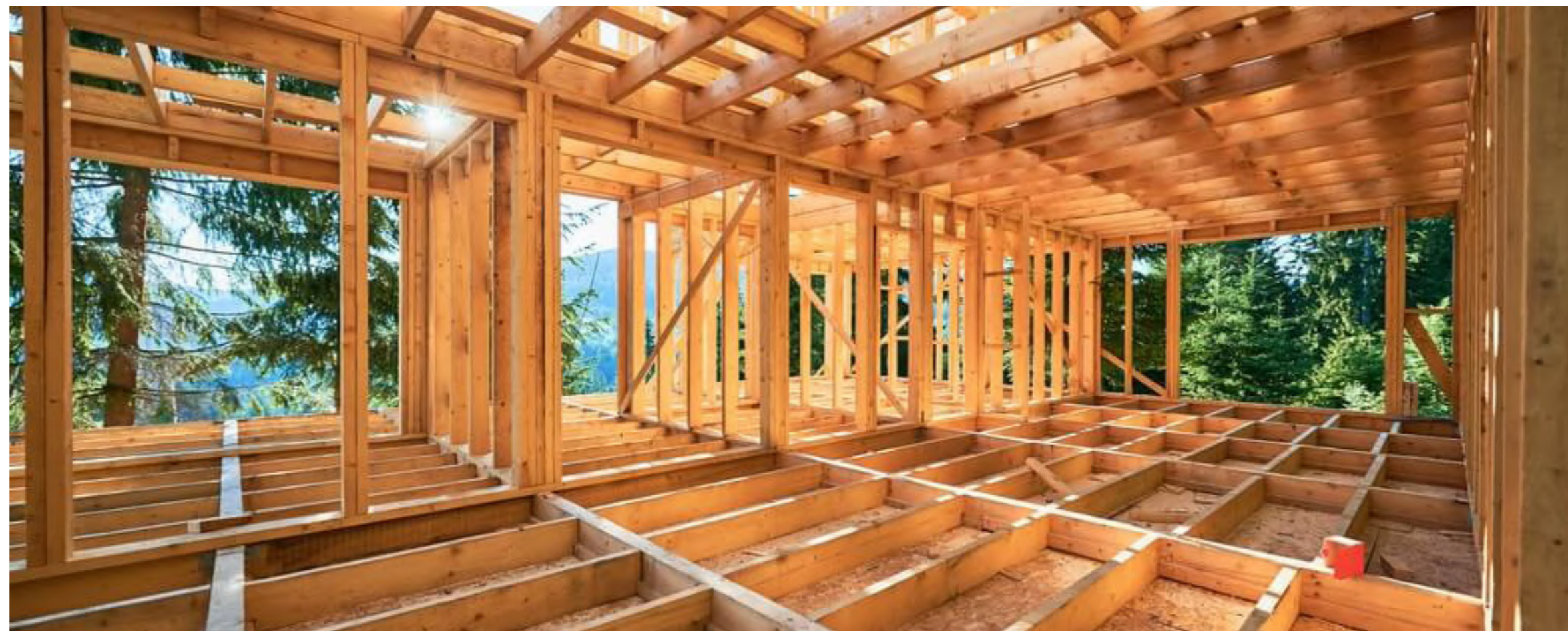
Figura No. 11. Sistema constructivo en madera con enfoque sostenible. Nota. Adaptado de Edificio con estructura de madera y diseño bioclimático [Fotografía], por Soler & Palau, 2019, Soler & Palau. https://www.solerpalau.com/blog/es-es/construccion-sostenible/
