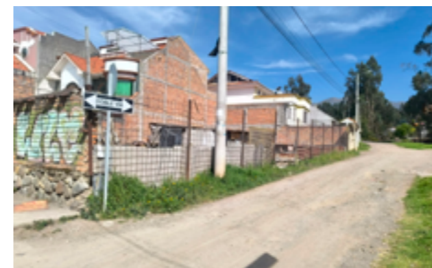
Imagen 25: C. de tierra. Fuente: Autoría propia (2025).
