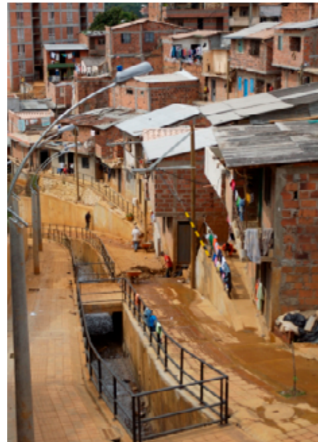
Imagen 11: Resultados de la intervención en la quebrada Juan Bobo [Fotografía], por Orsini, F, 2013, https://url-shortener.me/MEN4
