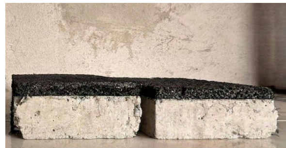
Figura 95 Sección transversal de baldosas con capa de caucho, espesor 25 mm y 20 mm, mostrando la interfaz hormigón-caucho.
