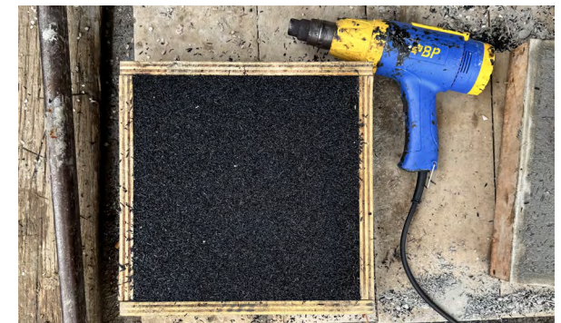
Figura 91 Capa de caucho totalmente compactada.
