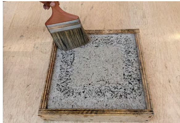
Figura 88 Limpieza con brocha de la cara vista de la baldosa seca.
