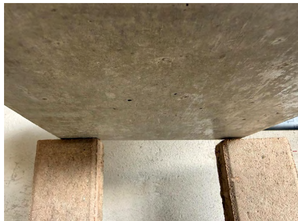
Figura 69 Cara inferior de la baldosa totalmente seca
