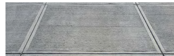
Figura 6 Acabado superficial de piso en hormigón escobillado con juntas de dilatación. Tomado de Manual de especificaciones y acabados de concreto, Holcim Ecuador.
