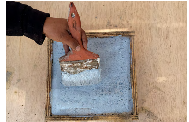
Figura 89 Aplicación de imprimante epoxídico Sikadur 32 primer.
