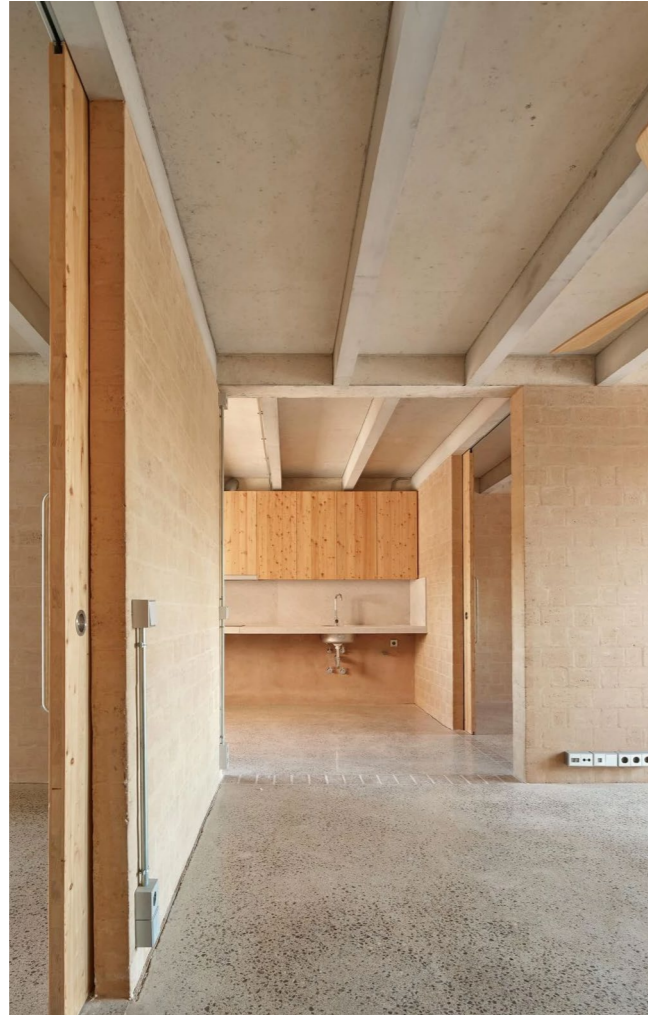
Figura 12. Espacio interior con muros portantes de BTC y organización modular. Fuente: Peris+Toral Arquitectes, 2022.
