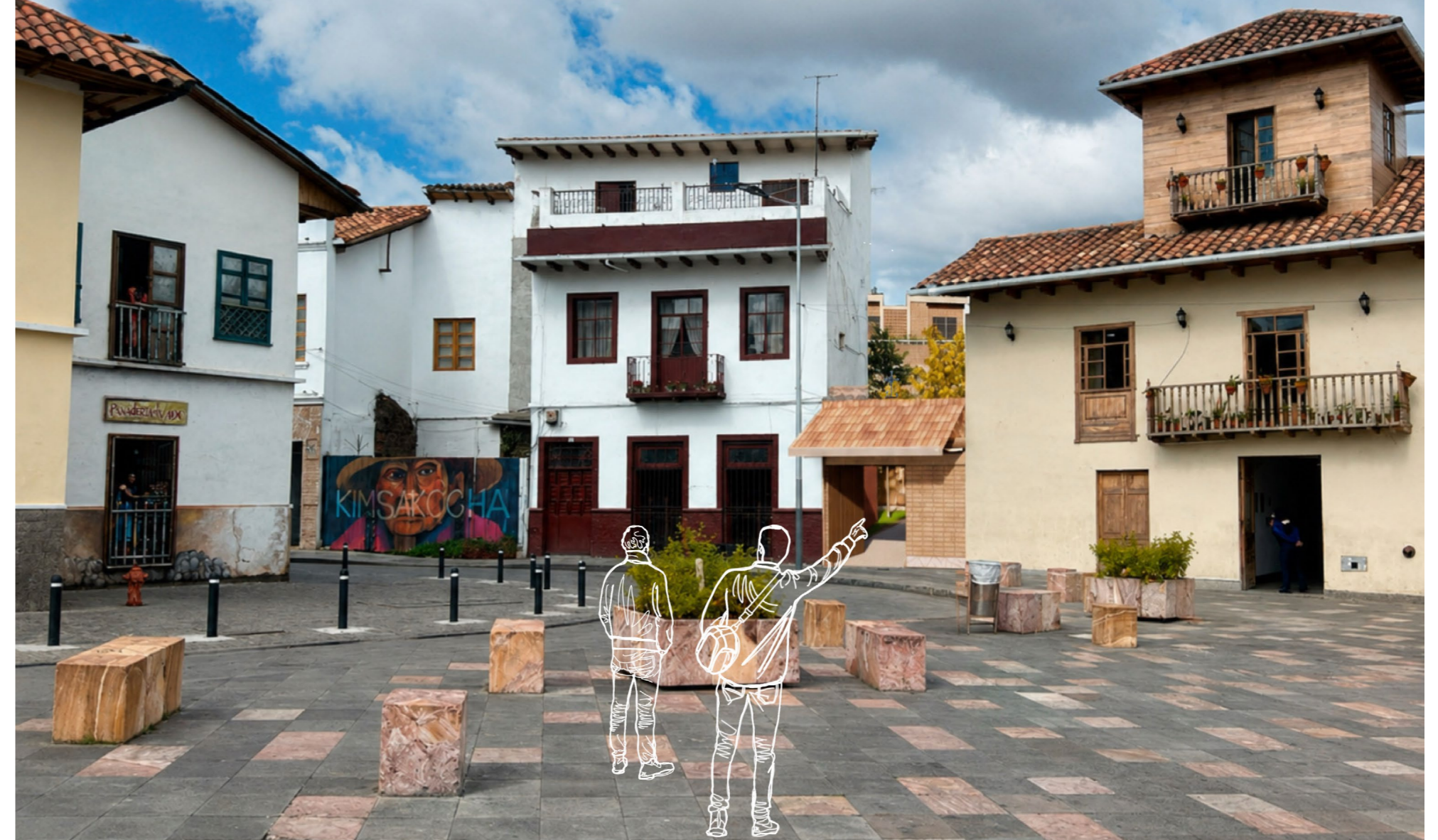
Figura 119. Vista del ingreso desde la plazuela Cruz del Vado. Autoría propia.
