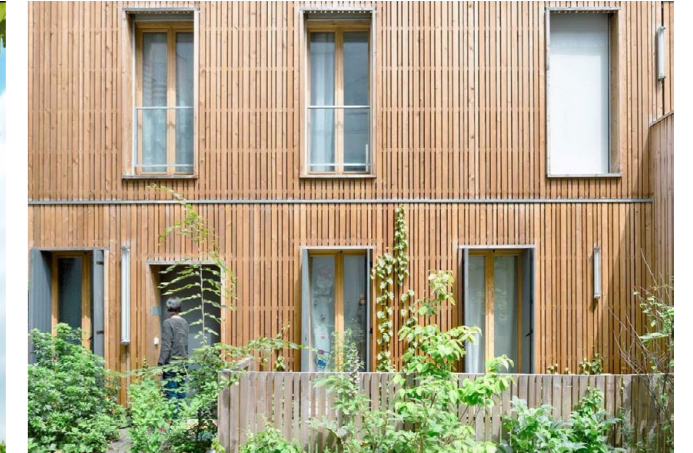
Figura 15. Fachada interior con balcones activos y circulaciones exteriores vinculadas al jardín común. Fuente: KOZ Architectes,2016.
