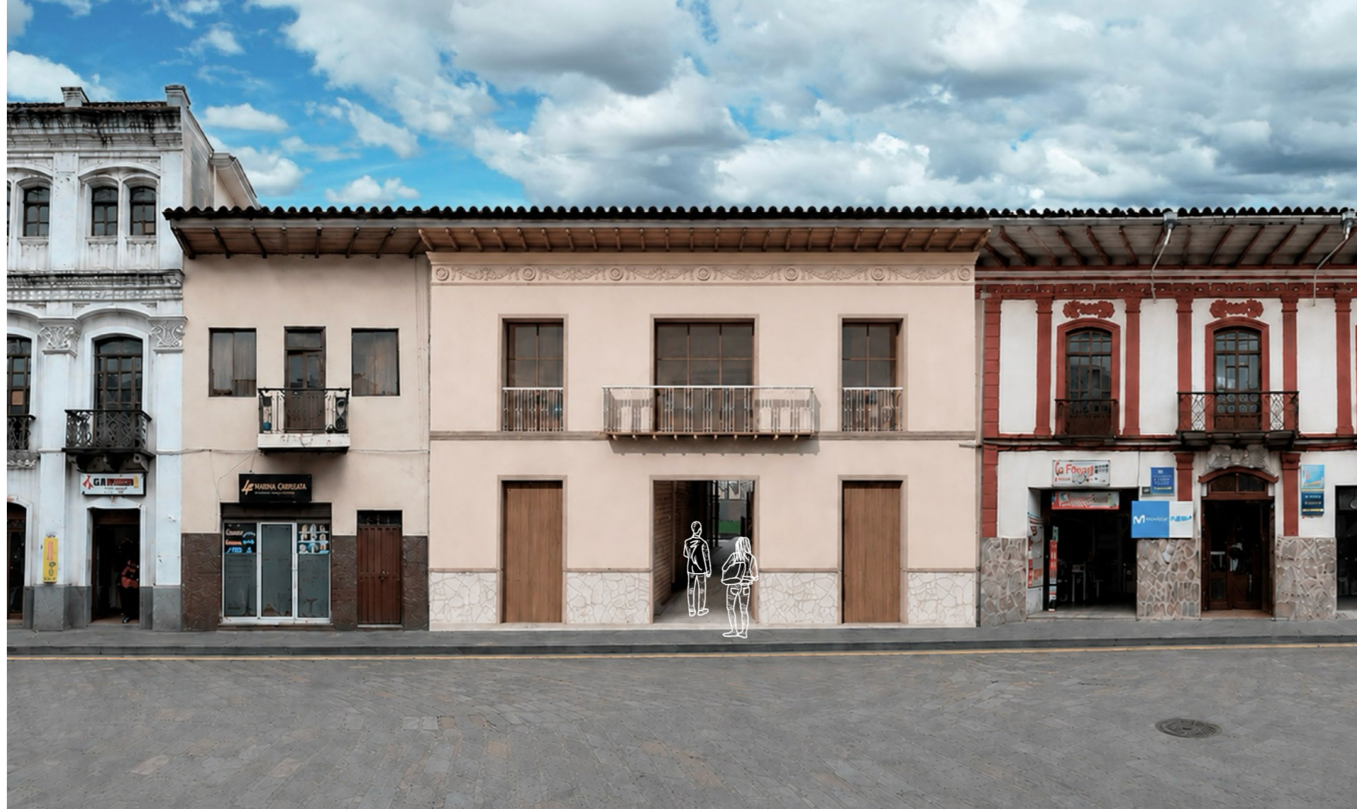
Figura 126. Vista de la fachada desde la Calle Tarqui. Autoría propia.
