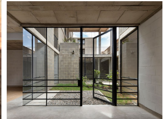
Figura 11. Vinculación visual entre espacios interiores y patios a través de elementos transparentes y balcones. Fuente: El Taller de S, 2019.
