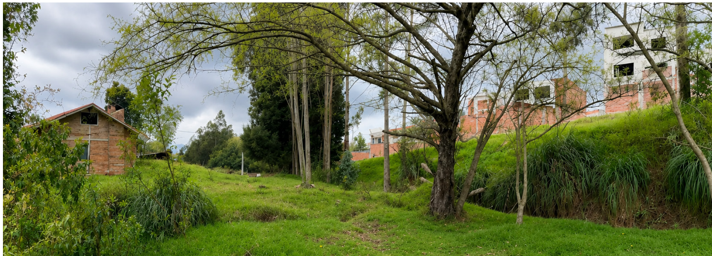
Figura 38. Foto de Sección 4: Vivienda que respeta los retiros.
