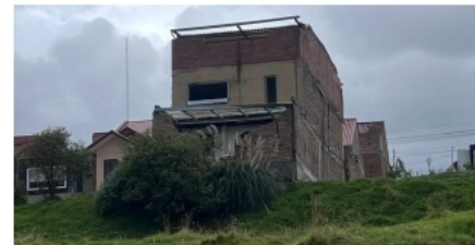
Figura 12. Construcciones en Suelo Inestable.
