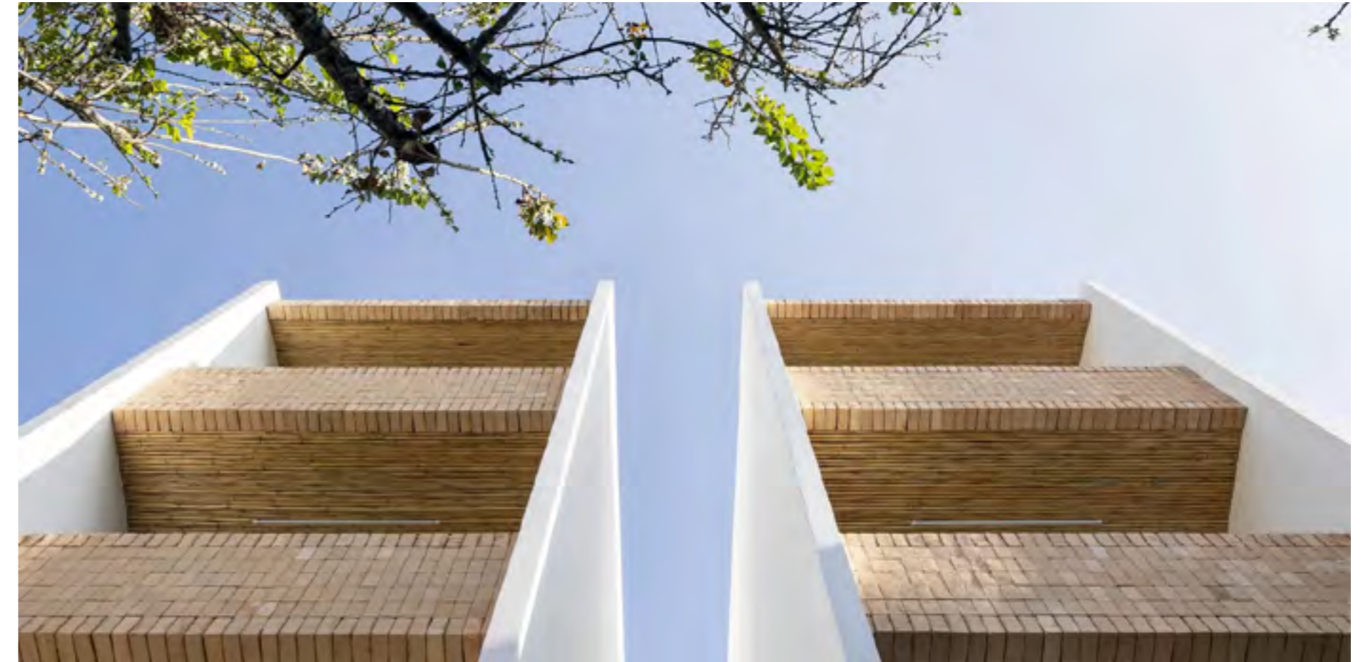
Figura 19: Fotografía de la fachada del edificio Entre patios. / Fuente: Jorge Jara, Bicubick, Juan Martín Cueva (2024).
