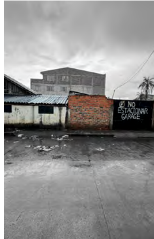
Figura 25: Vivienda precaria y muros ciegos.
