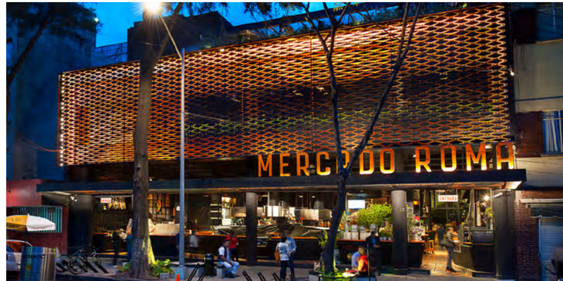
Figura 20: Fotografía de la fachada del edificio Mercado Roma. / Fuente: Jaime Navarro (2024).
