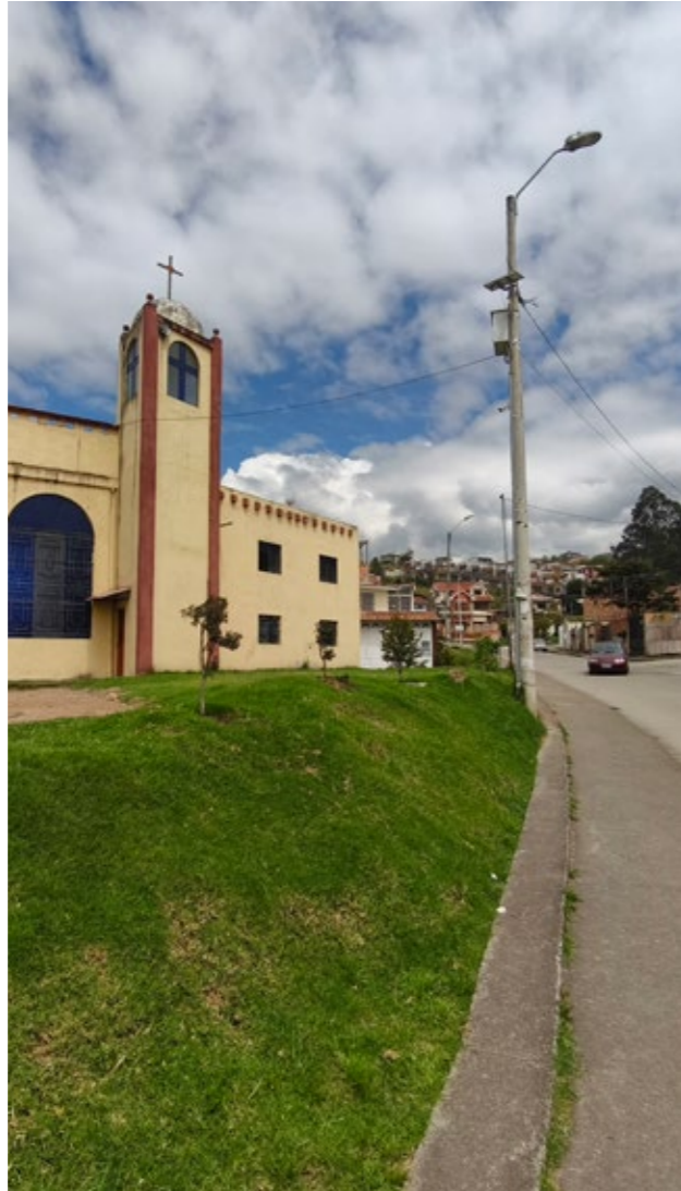
39. Vista de la superficie del embaulamiento junto a la Iglesia Católica Santa María del Tejar (Punto F). Fuente: Elaboración propia
