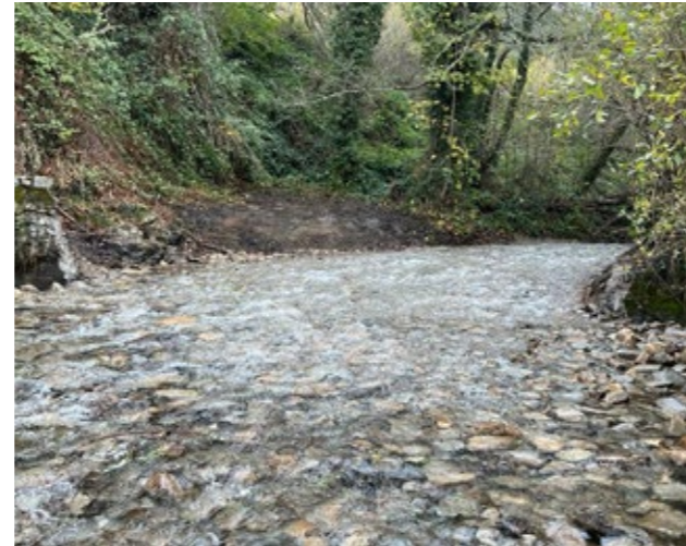
06. Río con continuidad tras la demolición del azud. Fuente: Ministerio para la transición ecológica y el reto demográfico en CH Cantábrico
