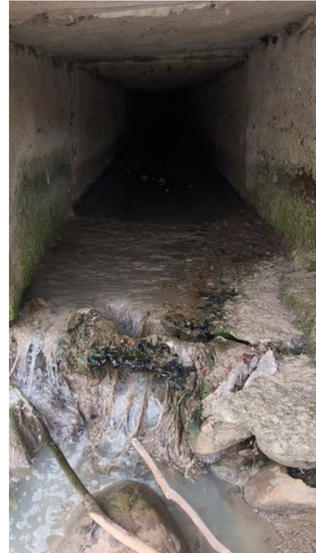
43. Punto de Descarga Final del Embaulamiento al Río Tomebamba (Punto J). Fuente: Elaboración propia
