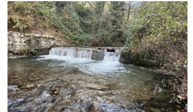
07. Azud en desuso que impide la continuidad. Fuente: Ministerio para la transición ecológica y el reto demográfico en CH Cantábrico
