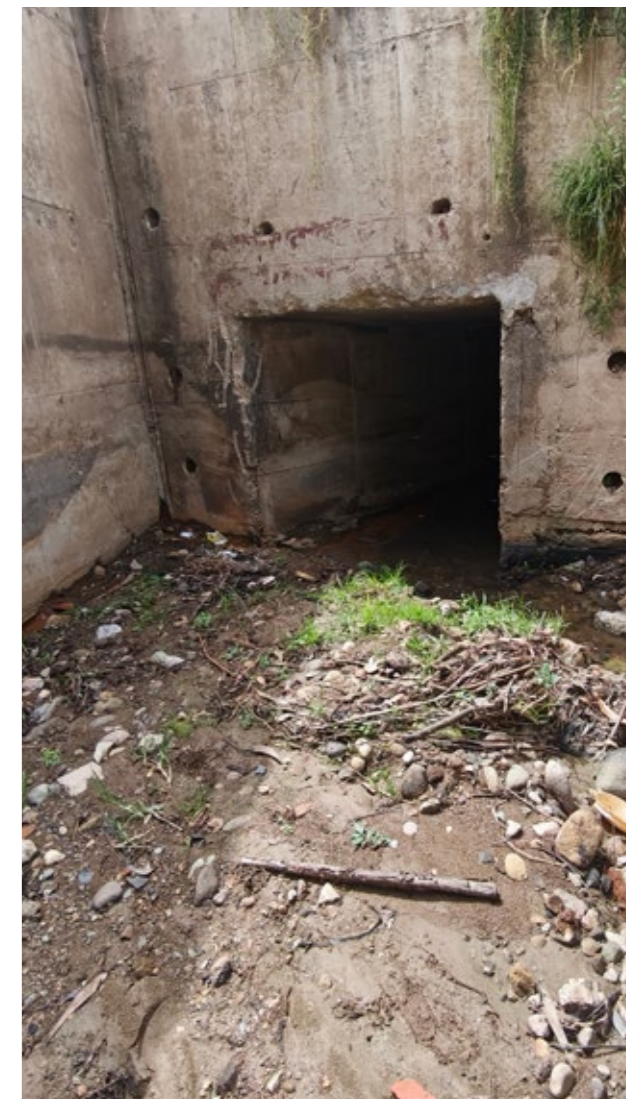
37. Vista del inicio del embaulamiento (Punto E). Fuente: Elaboración propia
