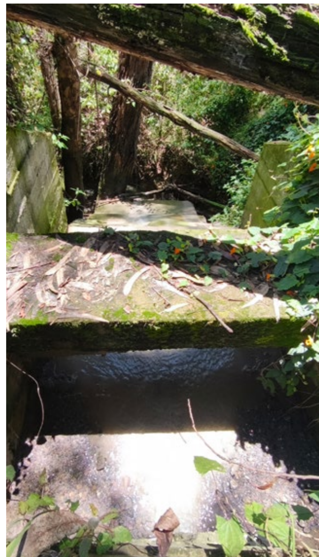
33. Vista de la Alcantarilla de Acceso al Tramo Entubado (Punto A). Fuente: Elaboración propia
