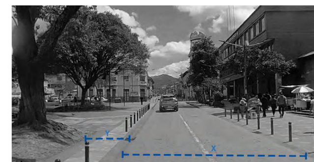
Figura 93. Calle Antonio Vega Muñoz Tramo 2 Fuente: Google Earth (2025)
