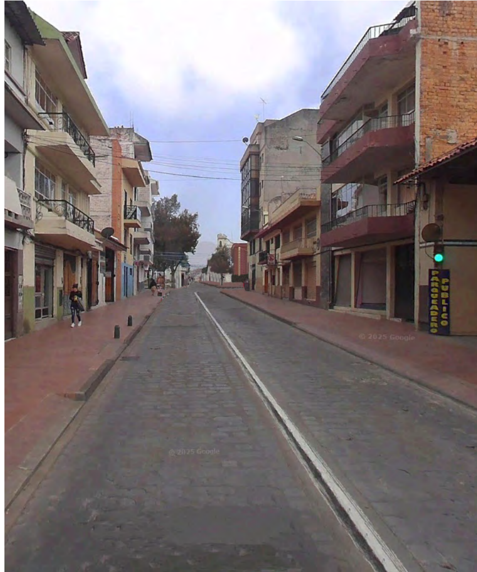
Figura 95. Perspectiva del estado actual de la vial en el sector María Auxiliadora. Adaptado de Google Earth (2025)
