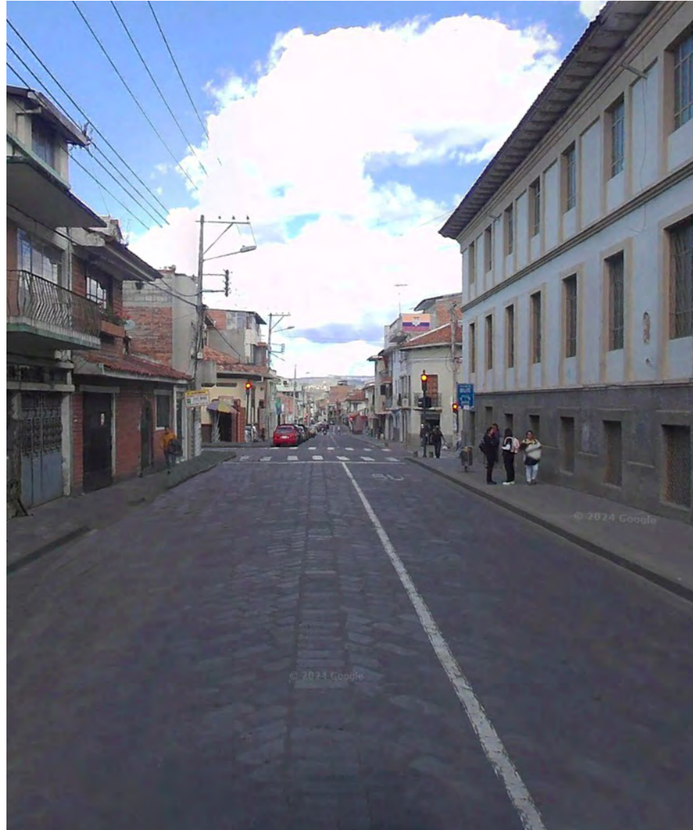
Figura 79. Perspectiva del estado actual de la vial en el sector María Auxiliadora. Adaptado de Google Earth (2025)
