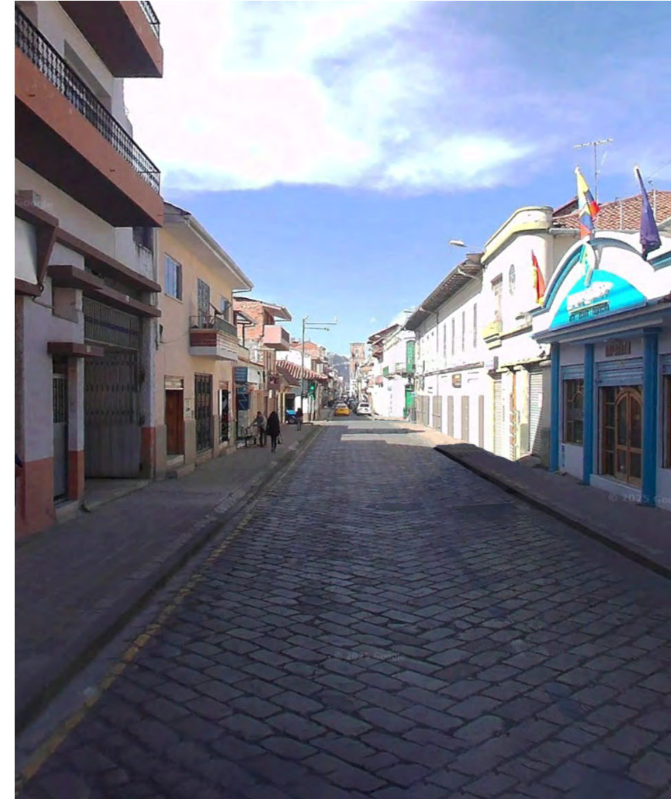
Figura 81. Perspectiva del estado actual de la vial en el sector María Auxiliadora. Adaptado de Google Earth (2025)
