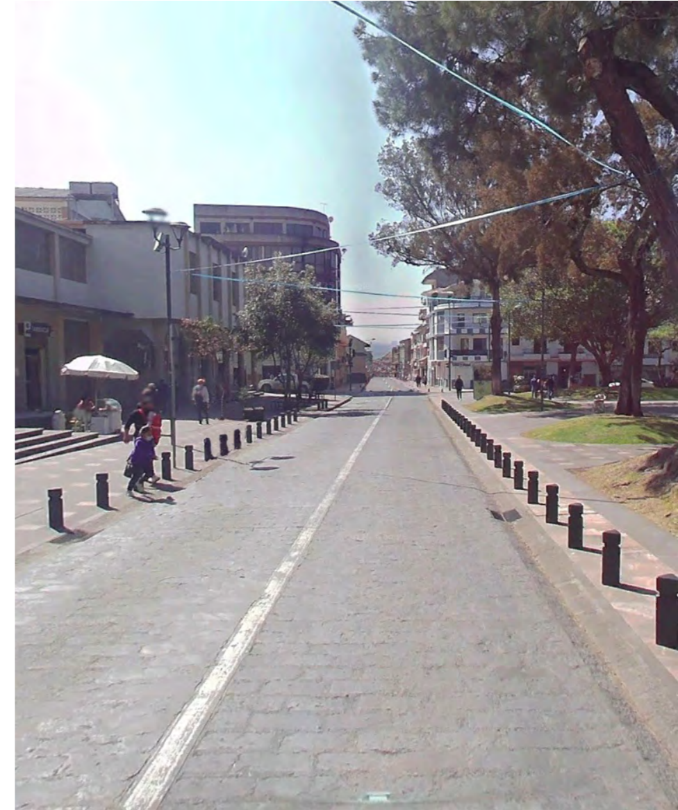
Figura 97. Perspectiva del estado actual de la vial en el sector María Auxiliadora. Adaptado de Google Earth (2025)
