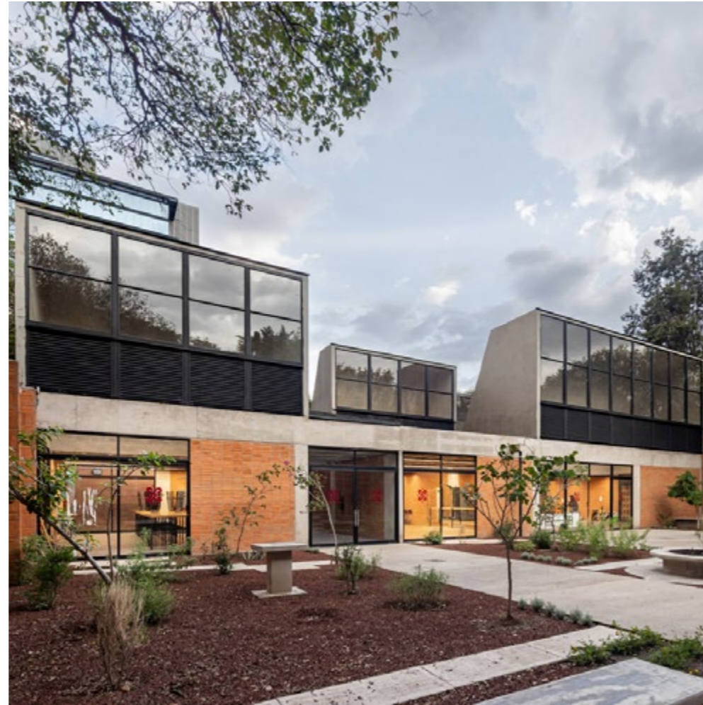
Imagen 14. Centro Comunitario PILARES, Archdaily
