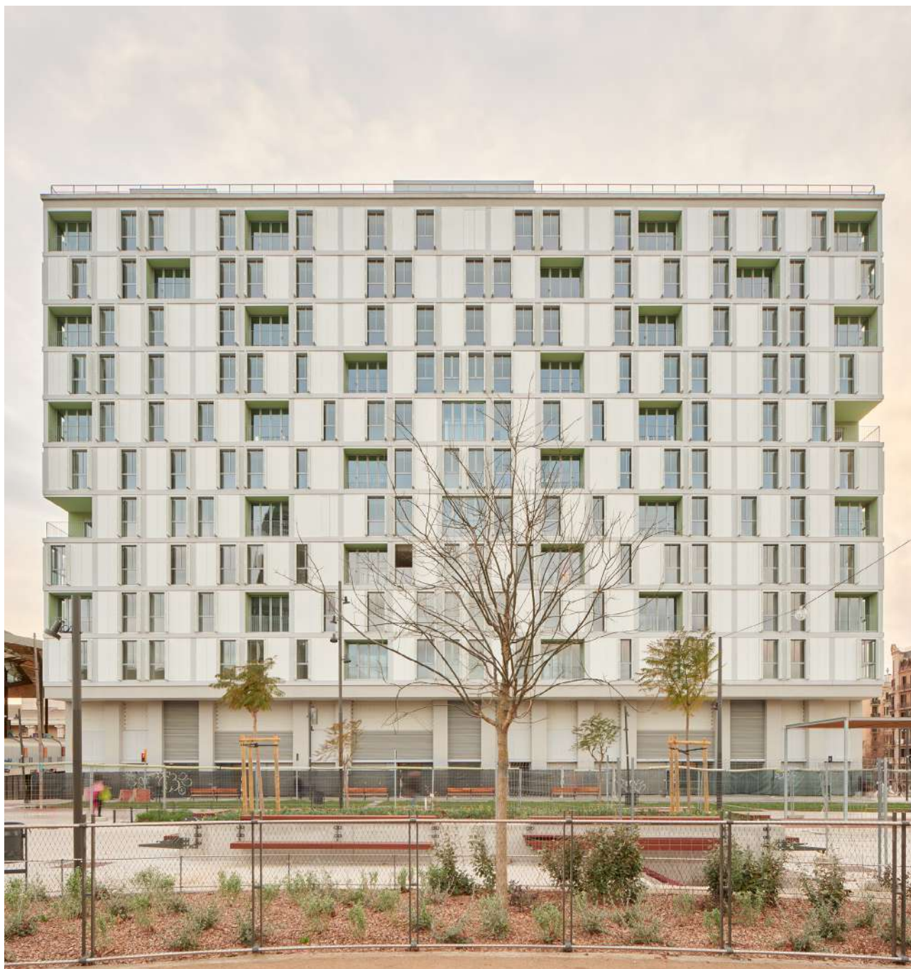
Fig.24. Fachada exterior. Bloque D en la illa glòries de Barcelona Fuente: SV60 arquitectos. Fotografía: José Hevia
