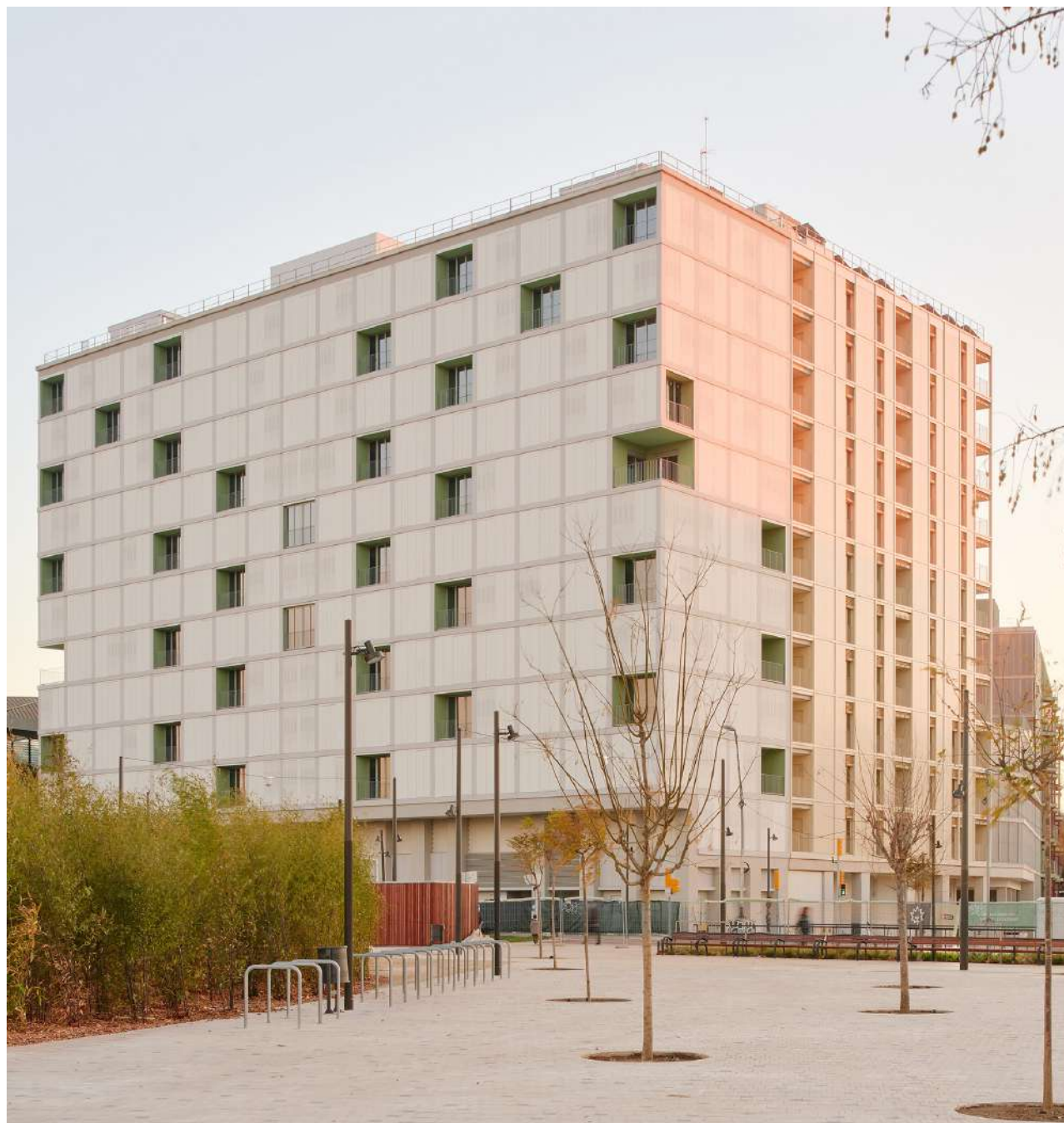
Fig.21. Fachada exterior 60 viviendas sociales. Bloque D en la illa glòries de Barcelona Fuente:SV60 arquitectos. Fotografía: José Hevia
