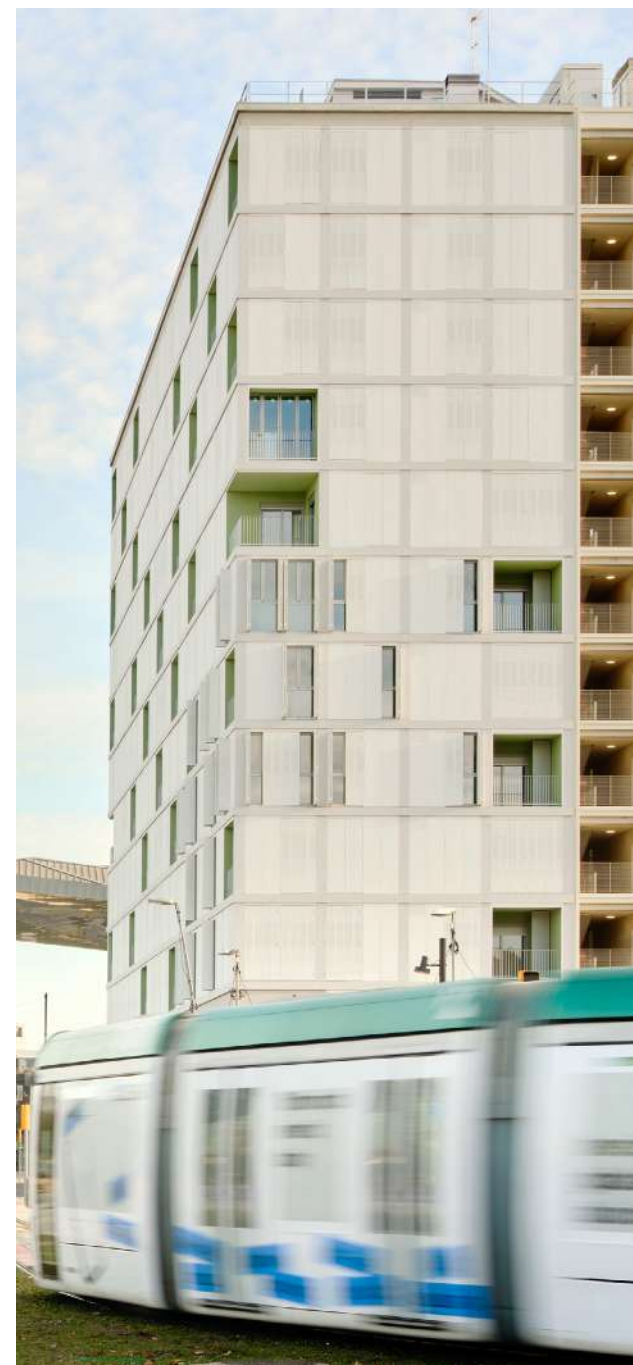
Fig.25. Fachada exterior. Bloque D en la illa glòries de Barcelona Fuente: SV60 arquitectos. Fotografía: José Hevia
