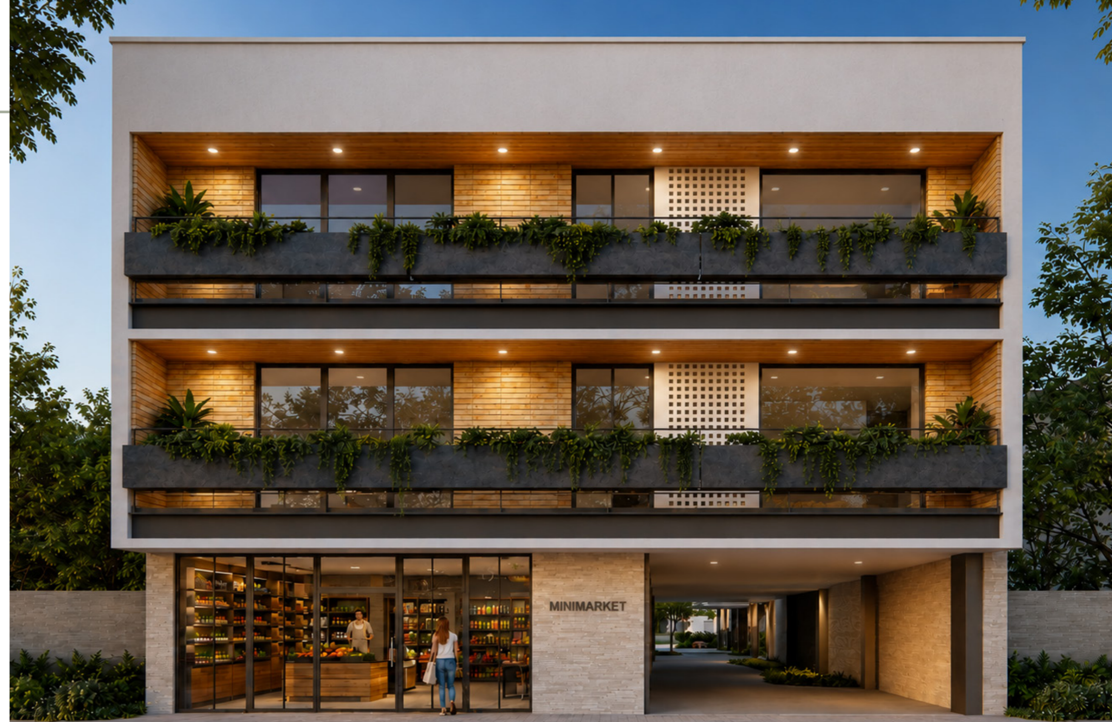
Figura 60. Fachada de bloque A. Nota. Elaboración propia.
