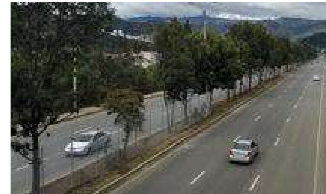
Figura 21: Autopista Cuenca-Azogues Fuente: Propia
