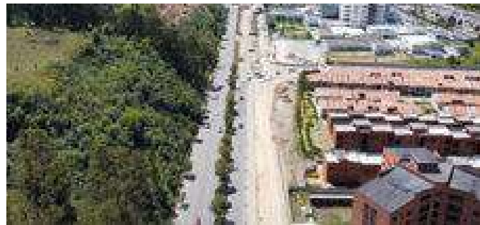
Figura 15: Autopista Cuenca-Azogues Fuente: Propia
