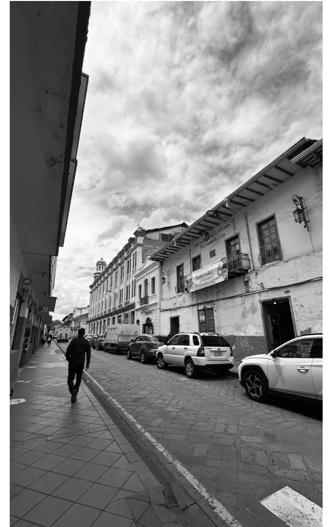
Figura 6. Vivienda deteriorada en la calle General Torres. Elaboración propia (2026).
