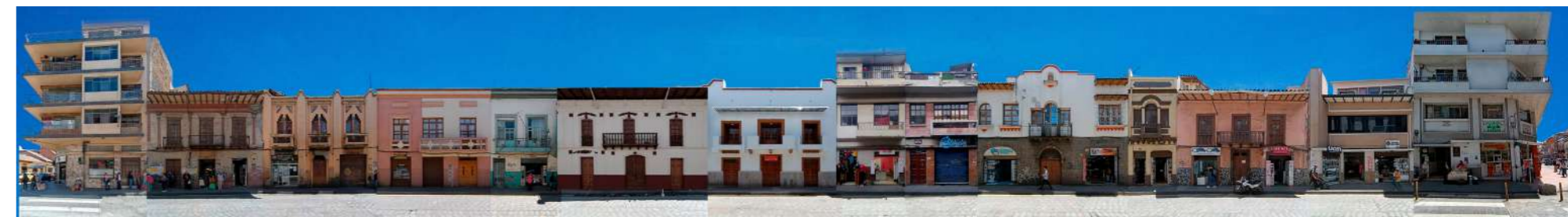
Fig. 13. Tramo de la calle Tarqui, entre la Presidente Córdova y calle Larga. Fuente: Fotografía tomada por los autores, 2026.
