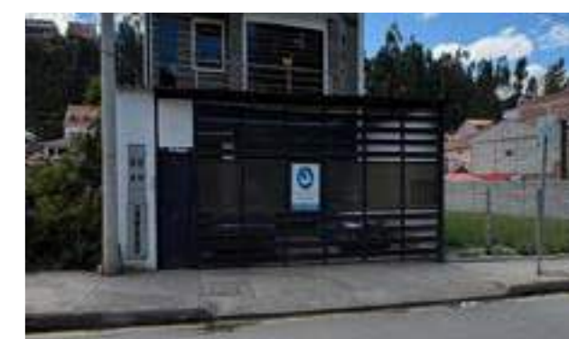
Figura 20. Equipamiento de culto. Fuente: archivo propio, 2026
