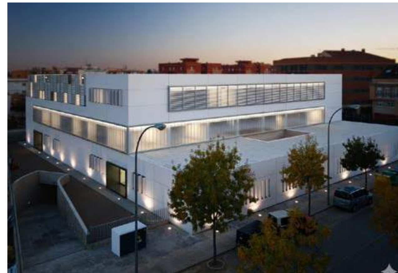
Figura 91. Vista noreste Fuente: Aitor Estevez
