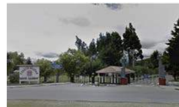
Figura 19. Equipamiento de seguridad. Fuente: Google maps, 2026
