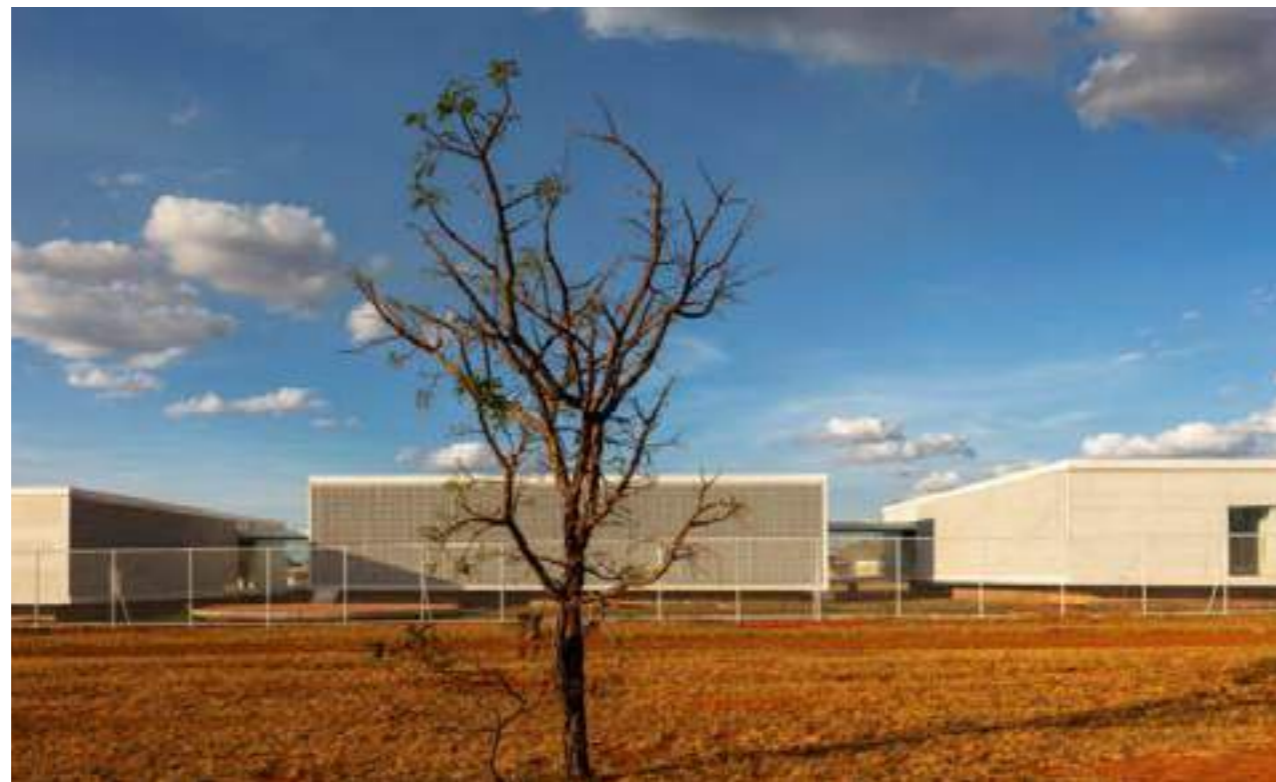
Figura 73. Vista frontal. Fuente: Leonardo Finotti
