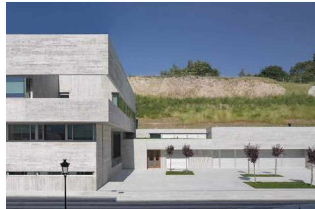
Figura 84. Plaza de acceso Fuente: IDOM Arquitectos
