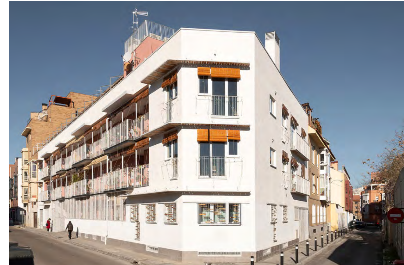
Fig. 18 Vista del chafalán, Cohousing Entrepatios
