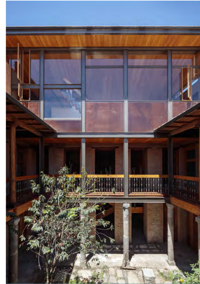
Fig. 50 Patio interno Fuente: Tomado de Espinoza (2024), ARQA.
