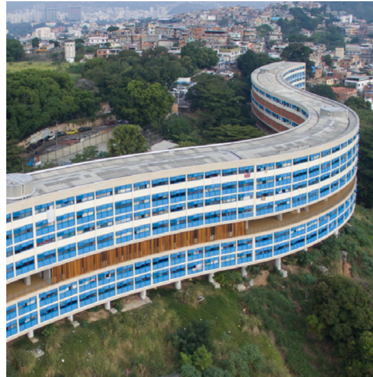
Figura 33 Conjunto residencial Prefeito Mendes de Moraes (Pedregulho), 1946-1958. Affonso Eduardo Reidy.
