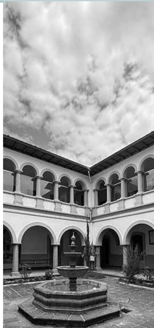
Figura 79. Estado actual de la pileta. Elaboración propia.
