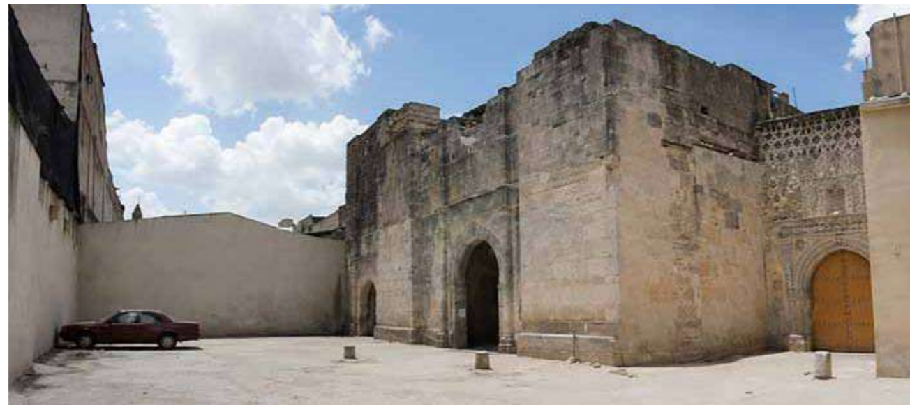
Figura 32. Estacionamientos antes de la demolición. Elaboración: Rocha & Carrillo (2012)
