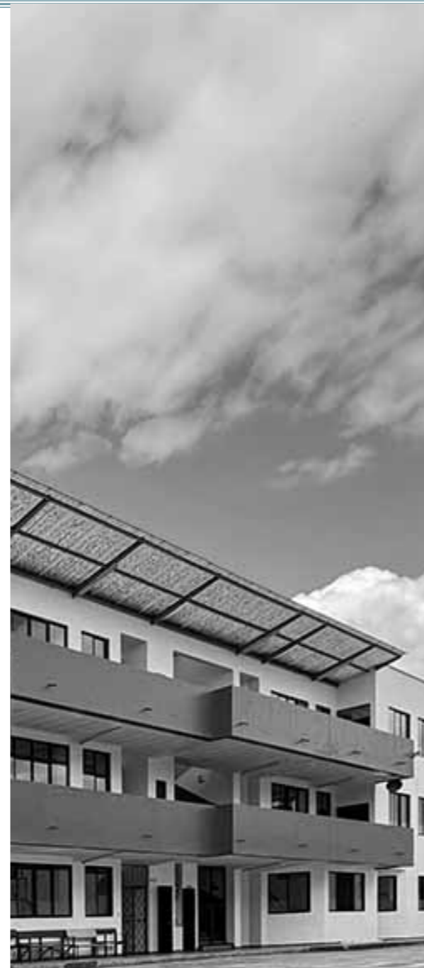
Figura 77. Estado actual de la escuela. Elaboración propia.
