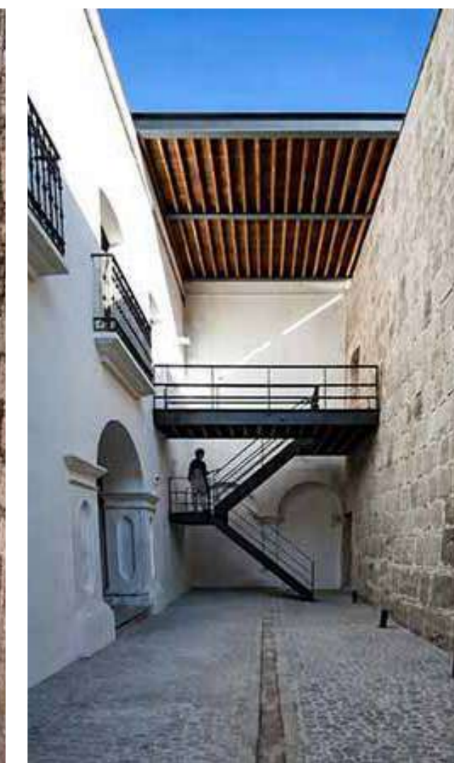
Figura 38. Intervención con arquitectura irreversible. Antes. Elaboración: Rocha & Carrillo (2016)
