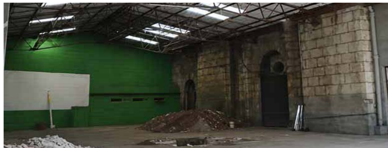
Figura 33. Bodegas antes de la demolición. Elaboración: Rocha & Carrillo (2012)
