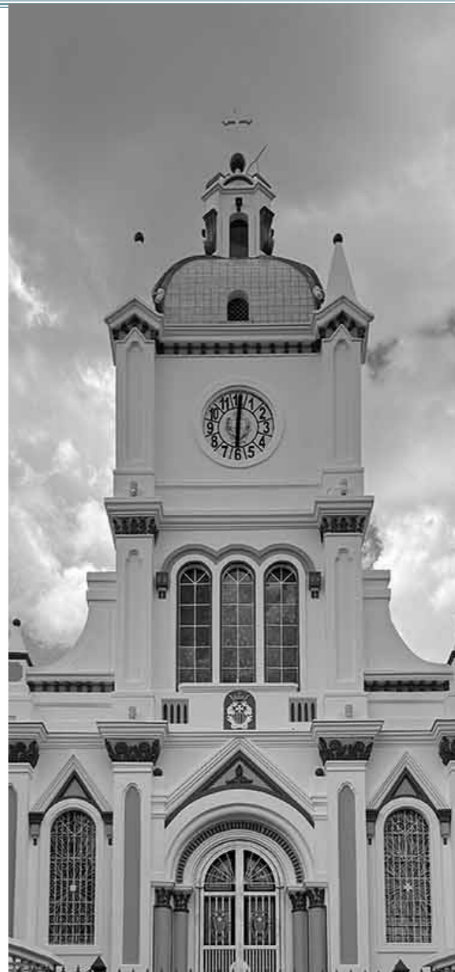
Figura 78. Estado actual de la iglesia. Elaboración propia.
