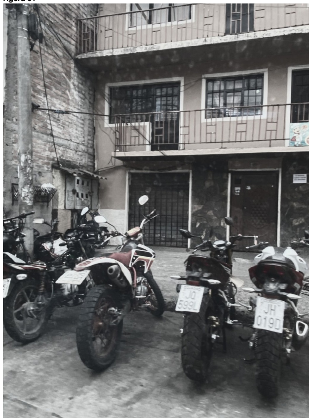
Fachadas llenas de rejas Fuente: Fotografía de la autora
