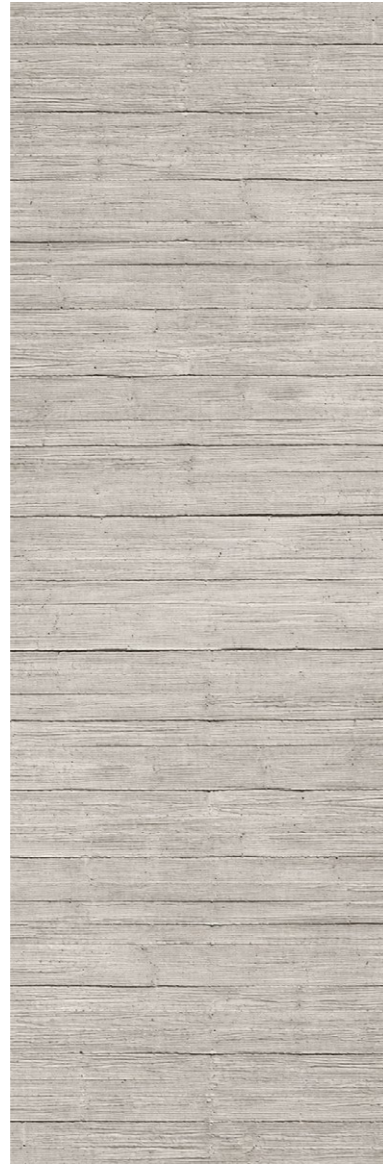
Hormigón texturizado por encofrado
