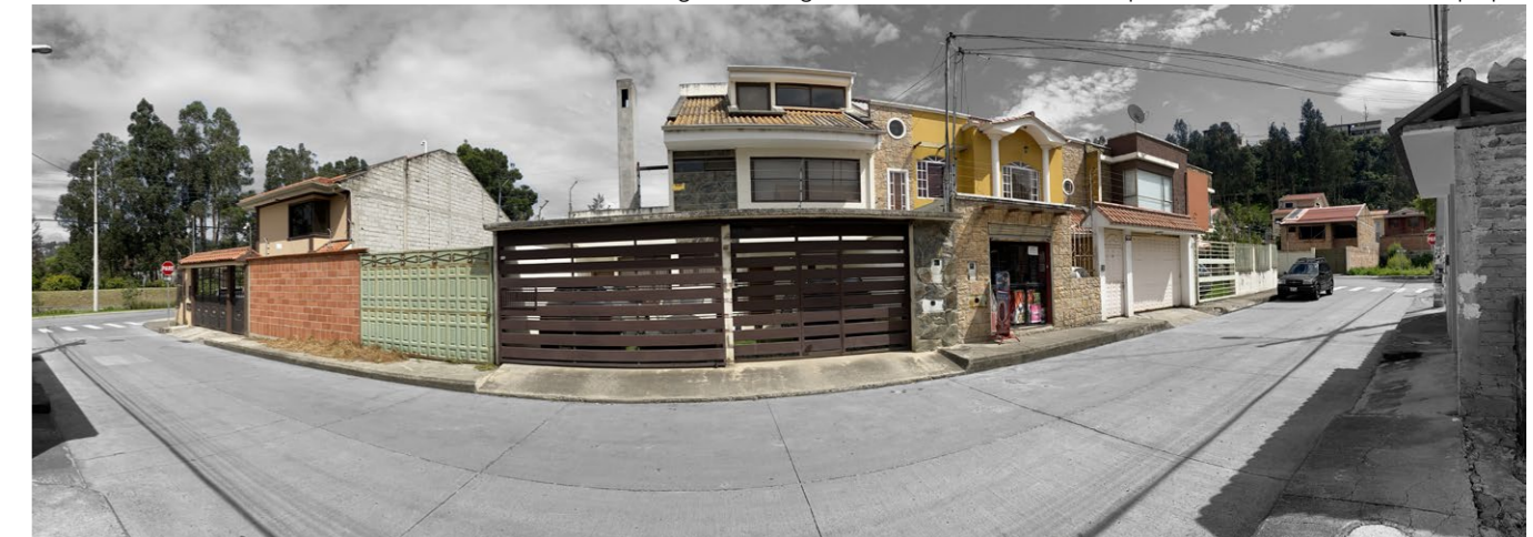
Figura 32. Fotografía de viviendas colindantes al predio seleccionado, elaboración propia.
