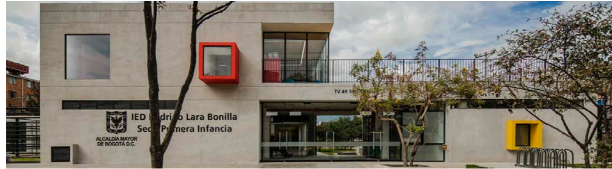
Figura 73. Fachada principal Nota: Jardín Infantil Rodrigo Lara Bonilla / FP Arquitectura. (2020), por Clara Ott. https://www.archdaily.cl/cl/939413/jardin-infantil-rodrigo-lara-bonilla-fp-arquitectura?ad_source=search&ad_medium=projects_tab
