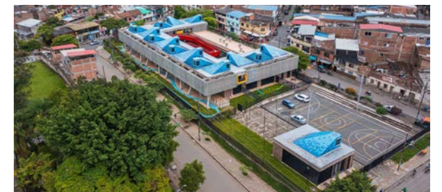
Figura 96. Áreas de uso comunitario Nota: Centro de desarrollo infantil Cuna de Campeones / Espacio Colectivo Arquitectos. (2022), por Agustina Coulleri. https://www.archdaily.cl/cl/993660/centro-de-desarrollo-infantil-cuna-de-campeones-espacio-colectivo-arquitectos
