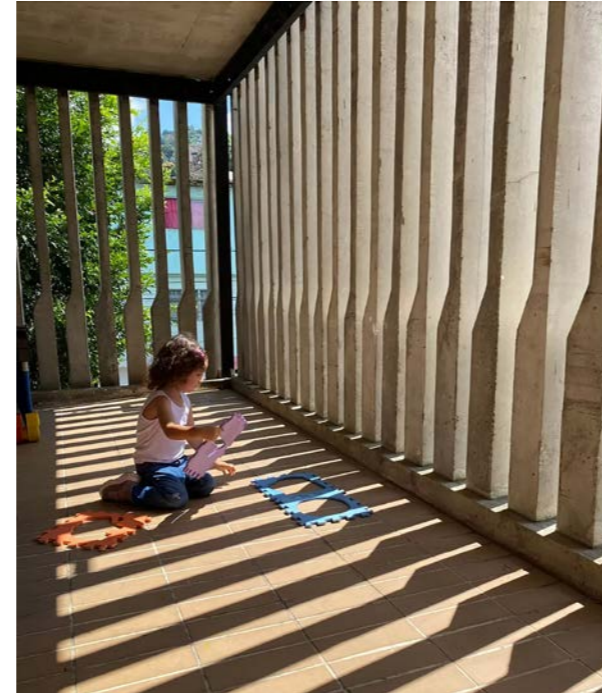
Figura 94. Persiana prefabricada de hormigón Nota: Centro de Desarrollo Infantil "Cuna de Campeones" - Siloé. (2022), por Espacio Colectivo Arquitectos. https://www.tallerespaciocolectivo.com/copia-de-invernadero-vernaculo-1
