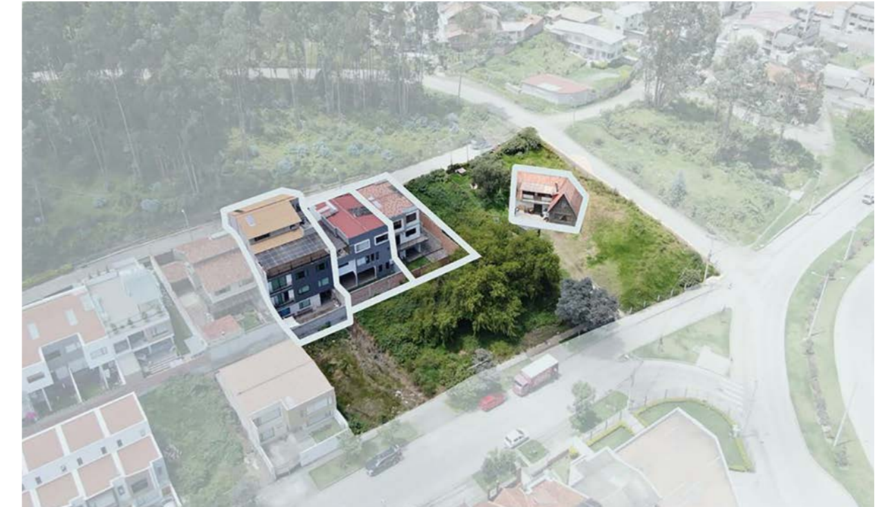
Figura 59. Viviendas a demoler Nota: Autoría Propia
