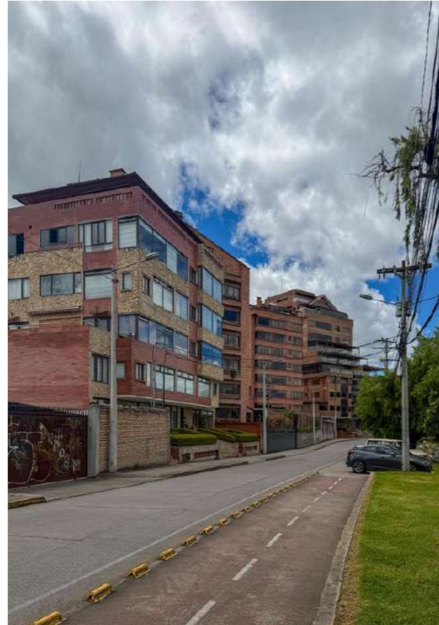
Figura 162: Av. 3 de noviembre (edificios frentistas). Fuente: Elaboración propia (2026)
