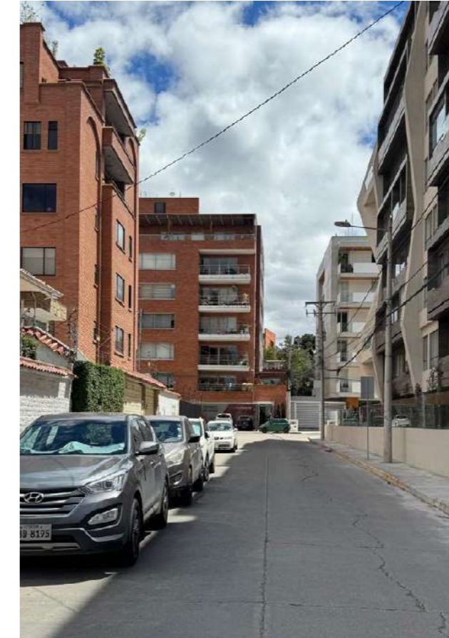
Figura 165: Av. 1ro de mayo (edificios en construcción). Fuente: Elaboración propia (2026)
