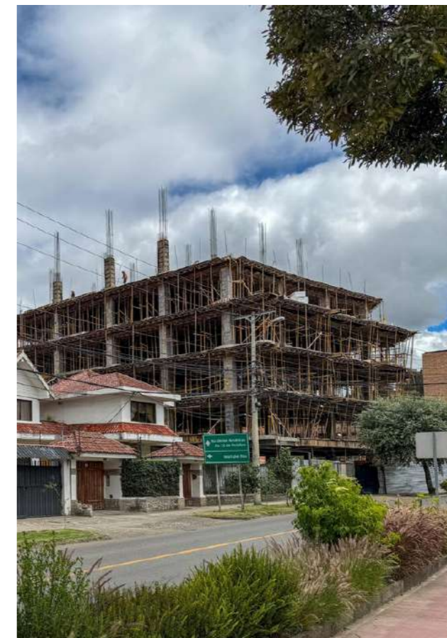
Figura 161: Av. 1ro de mayo (edificios en construcción). Fuente: Elaboración propia (2026)
