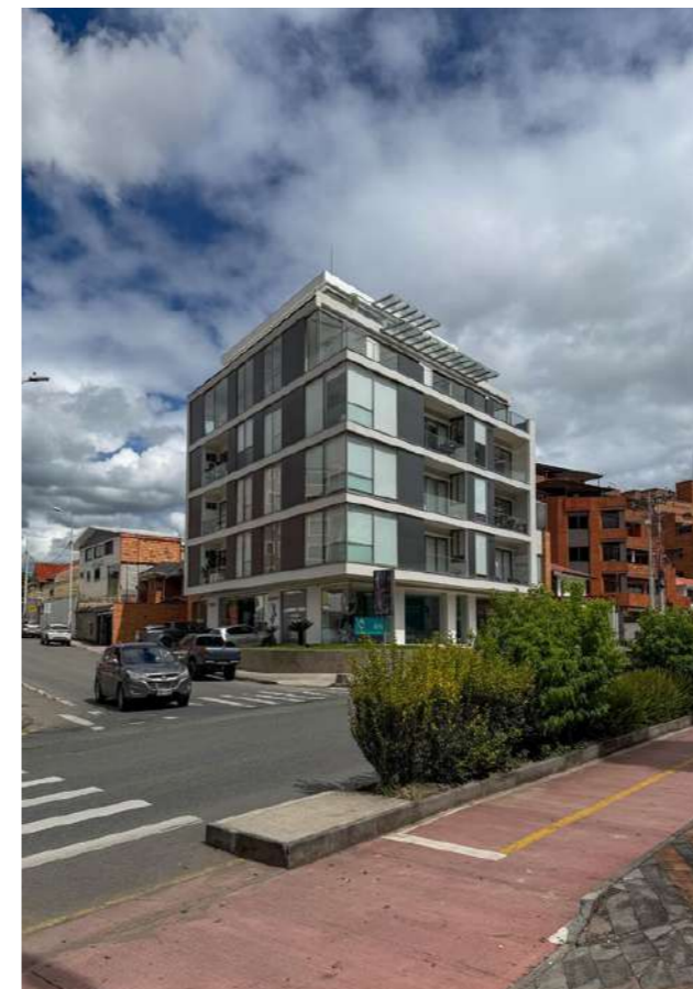
Figura 160: Av. 1ro de mayo (vía secundaria). Fuente: Elaboración propia (2026)
