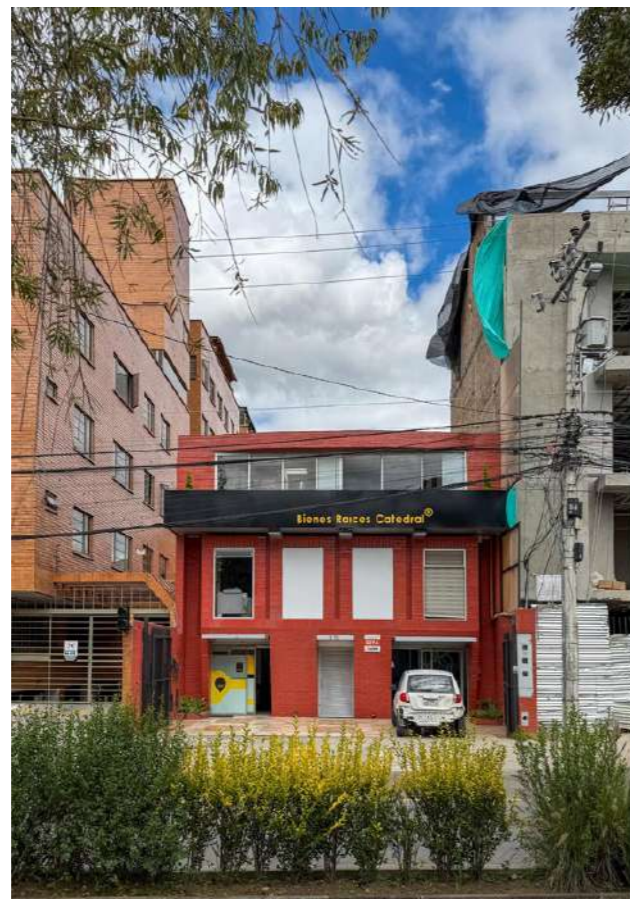
Figura 158: Av. 1ro de mayo (casa entre dos edificios). Fuente: Elaboración propia (2026)
