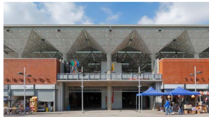
Figura 59: Acceso principal del mercado Tirso de Molina Fuente: Plataforma digital "Archdaily" - Mercado Tirso de Molina (2011)
