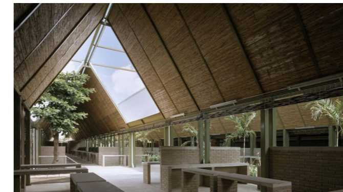
Figura 52: Interior del mercado Guadalupe Fuente: Plataforma digital "Archdaily" - Mercado Guadalupe (2021)
