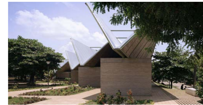
Figura 53: Exterior del mercado Guadalupe Fuente: Plataforma digital "Archdaily" - Mercado Guadalupe (2021)
