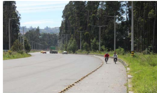
Figura 23: Estado actual de la ciclovía en la Av. de los Migrantes Fuente: Elaboración propia
