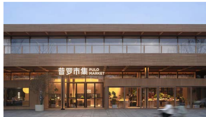
Figura 54: Fachada frontal del mercado Pulo Fuente: Plataforma digital "Archdaily" - Mercado Pulo (2022)
