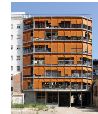
Fuente: Lacol (2018) Figura 50: Elementos de protección solar
