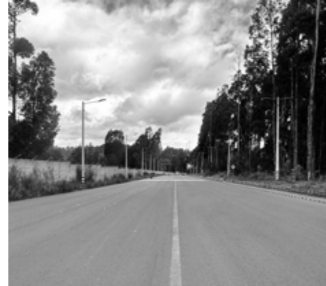
IMG 32. Condición actual de la Av. de los Migrantes - Tramo 2 Fuente: Autoría propia
