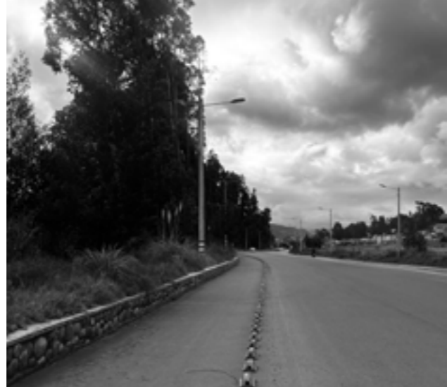
IMG 29. Condición actual de la Av. de los Migrantes - Tramo 1 Fuente: Autoría propia
