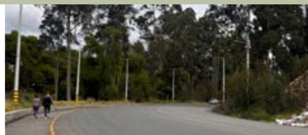
IMG 26. Peatones utilizando la ciclovia ante la ausencia de veredas
