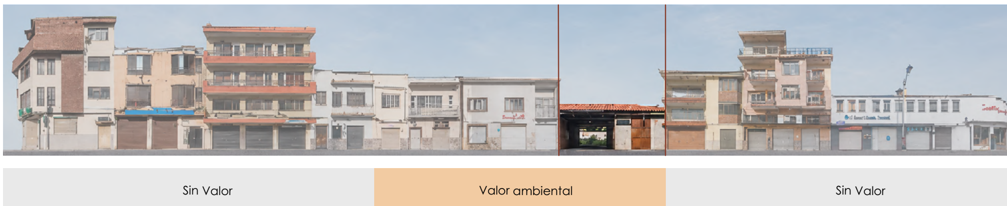
Figura 95 Levantamiento de Tramo de la calle Tomás Ordóñez_Estado Actual Nota. Autoría propia.
