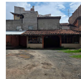
Figura 54 Fotografía desde el patio Nota. Arq. Álvaro Maldonado.
