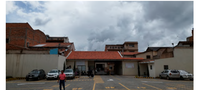
Fig 48 Fotografía 01 Parqueadero Pío XII (Interior) Nota. Autoría propia.
