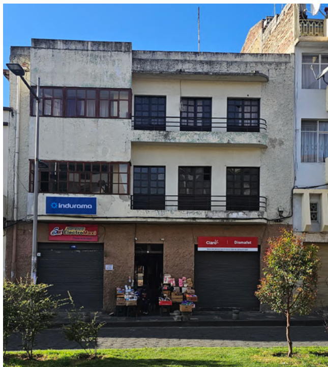
Figura 51 Fotografía Fachada Nota. Autoría propia.
