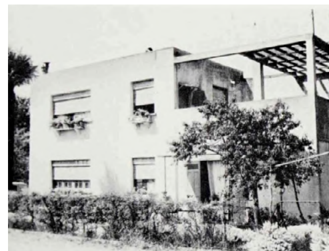
Figura 5 Fotografía del Conjunto de LeCorbusier en Pessac, tras adaptaciones Nota. De Lived-in architecture Le Corbusier's Pessac revisited by Boudon, Philippe (1969).
