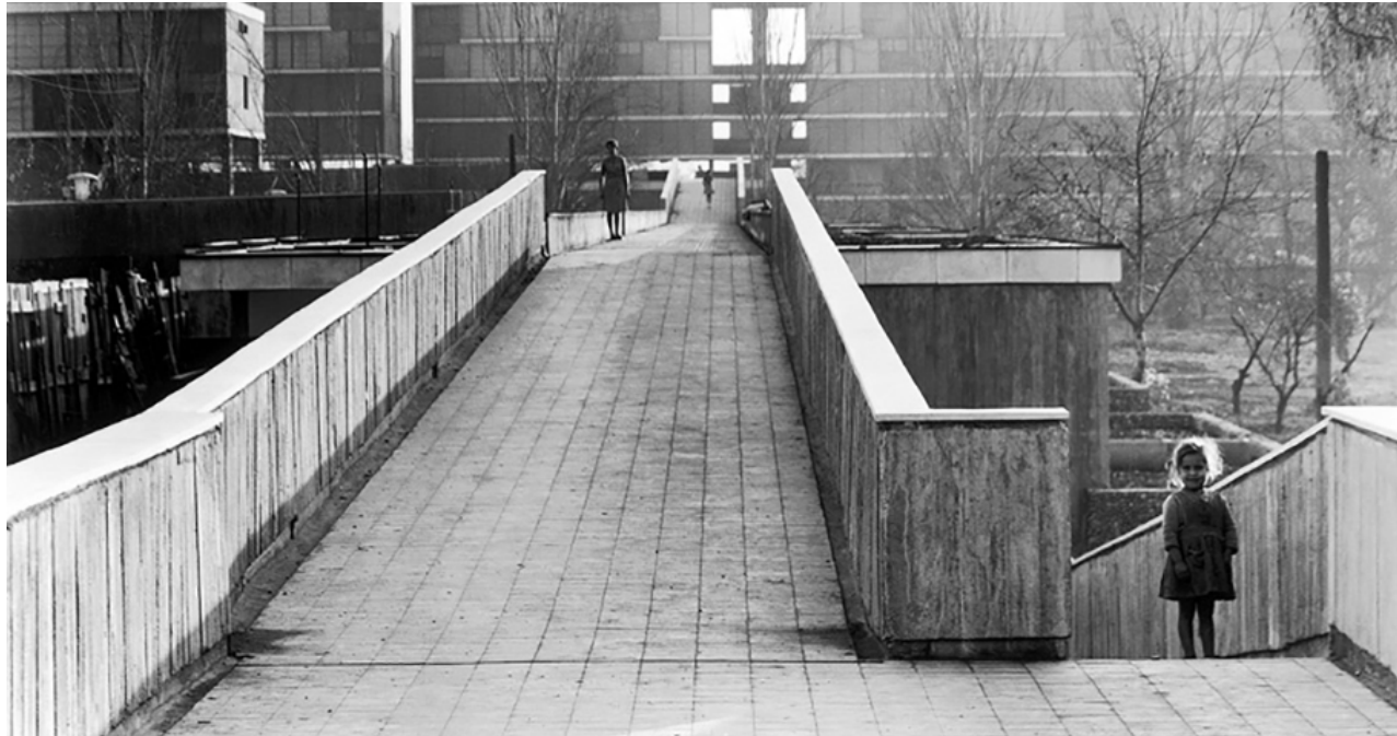
Fig 29: Pasarelas peatonales años 60 Fuente: HiddenArchitecture 2019
