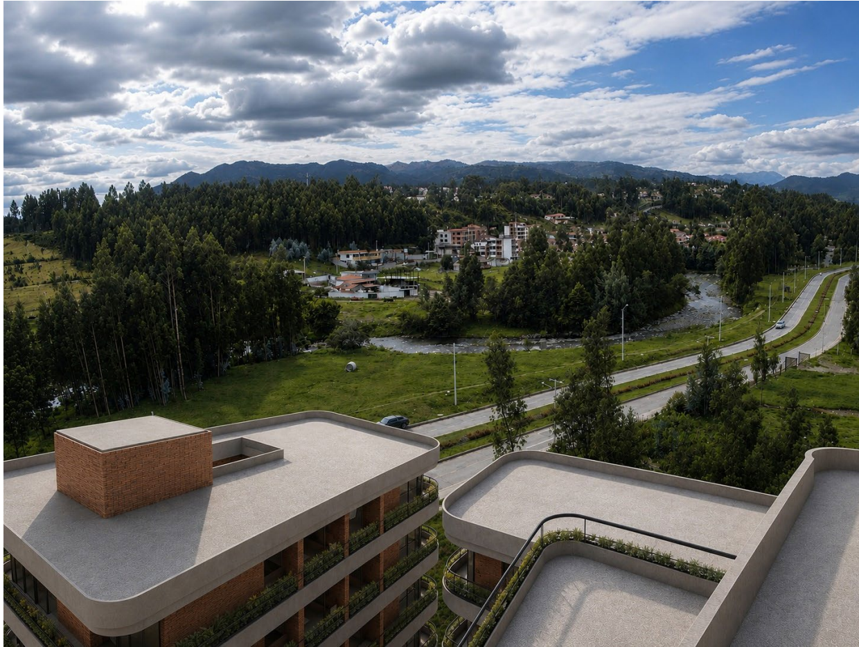
Fig 147: Vista desde la cubierta del Bloque de siete pisos
