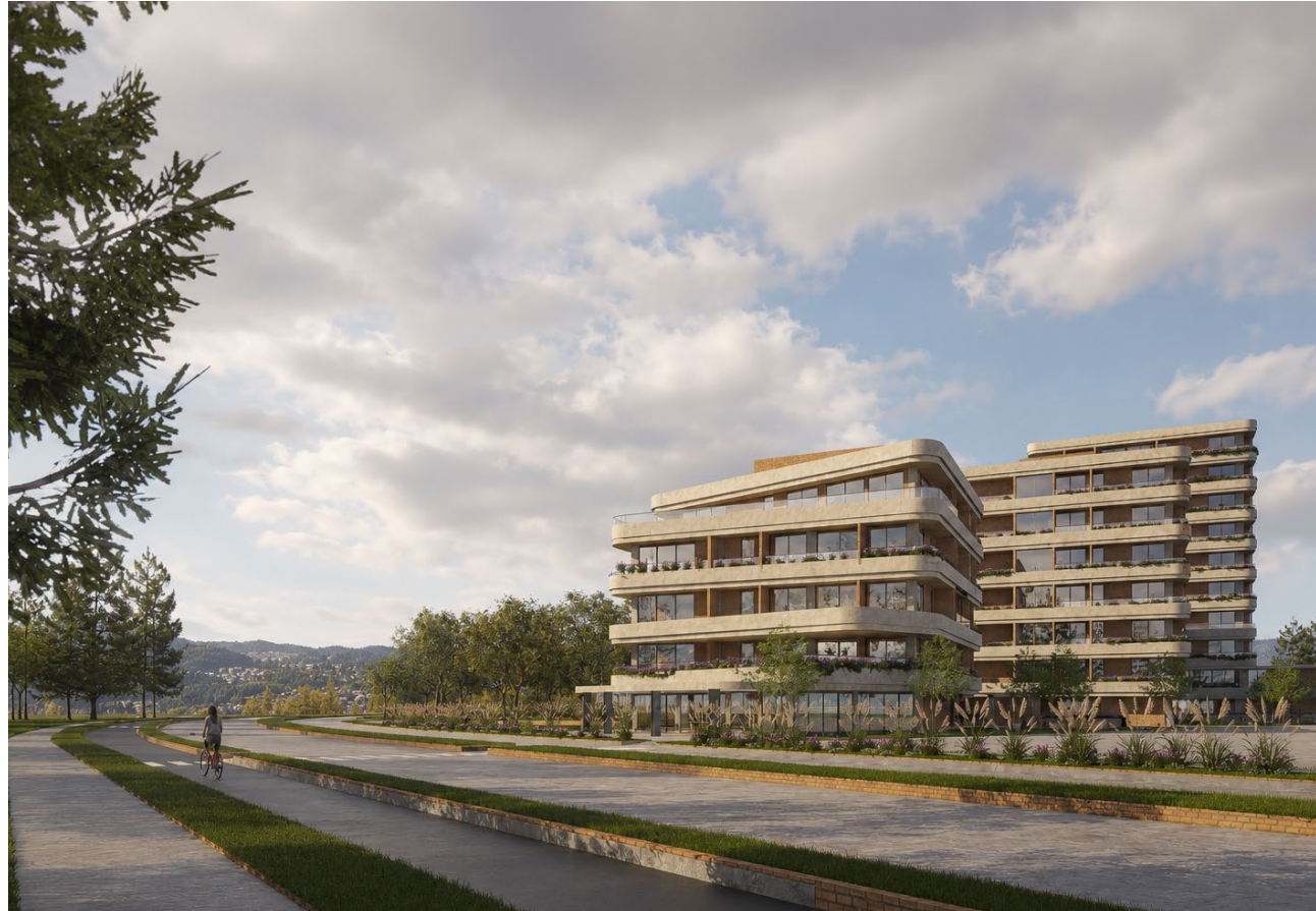
Fig 119: Vista desde ciclovía. Elaboración Propia 2026
