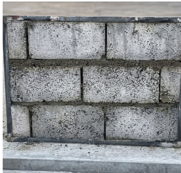
Figura 19: Colocación de bloques en panel, Jorge Morales , 2022
