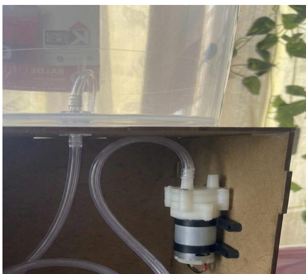
Fig. 7. Instalacion de bomba y sensor de nivel
