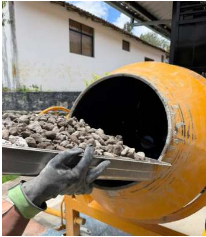
Figura 69. Mezclado de las diferentes dosificaciones mediante el uso de la concreteira.
