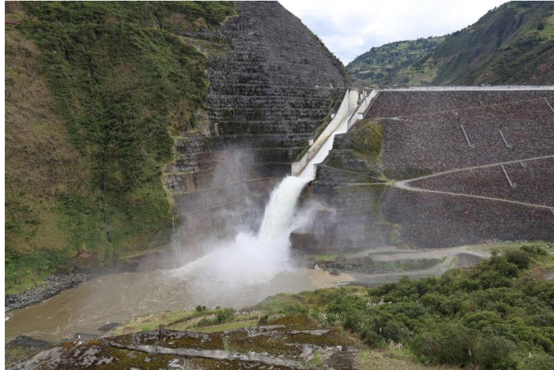
Central Hidroeléctrica Mazar
