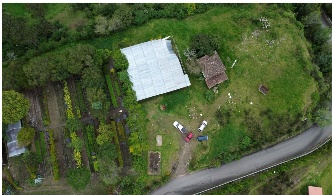
Imagen 4: Ortofoto general capturada con dron, infraestructuras existentes Fuente: Elaboración propia.
