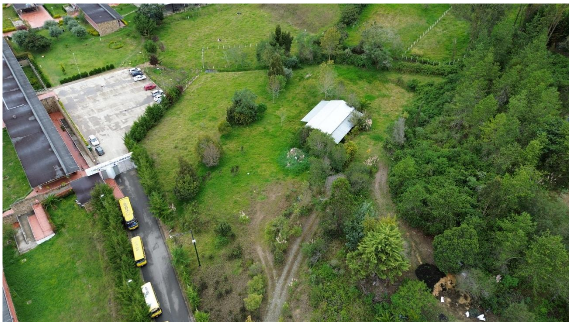
Imagen 3: Ortofoto general capturada con dron, infraestructuras existentes Fuente: Elaboración propia.
