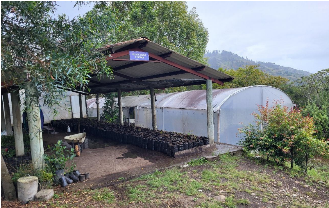
Imagen 7: Infraestructura existente Fuente: Elaboración propia
