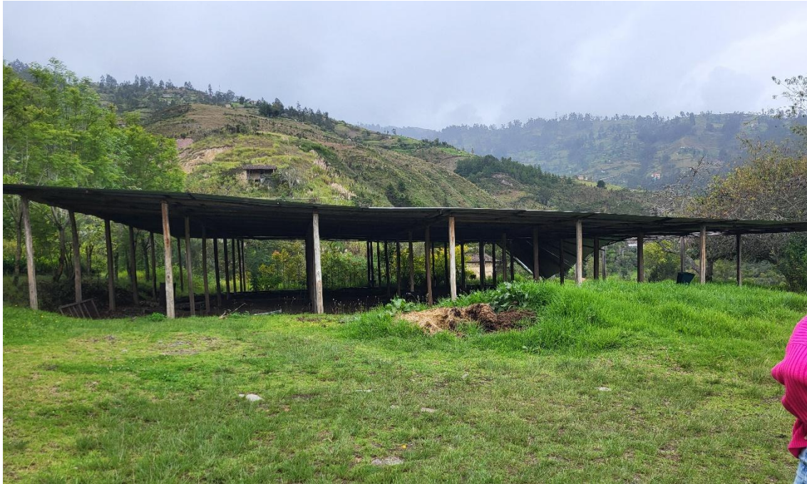
Imagen 6: Infraestructura existente Fuente: Elaboración propia
