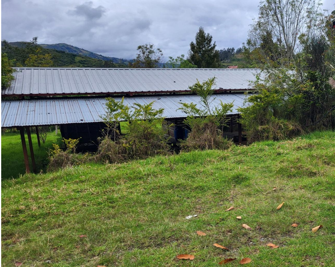
Imagen 8: Infraestructura existente Fuente: Elaboración propia
