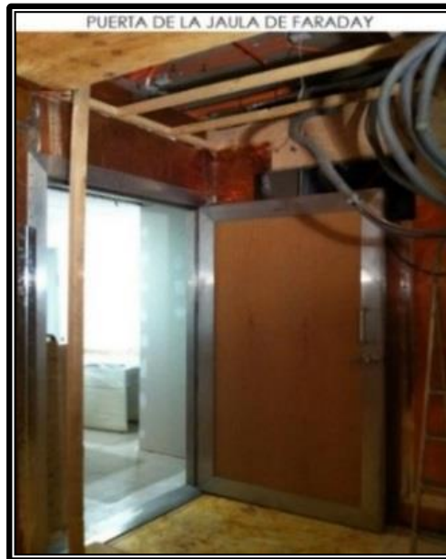
Figura 2.5. Puerta construida para una Jaula de Faraday.
