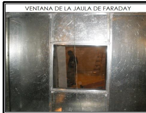
Figura 2.7. Ventana construida para una Jaula de Faraday.
