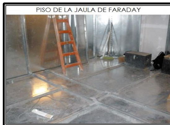
Figura 2.2. Piso construido para una Jaula de Faraday.
