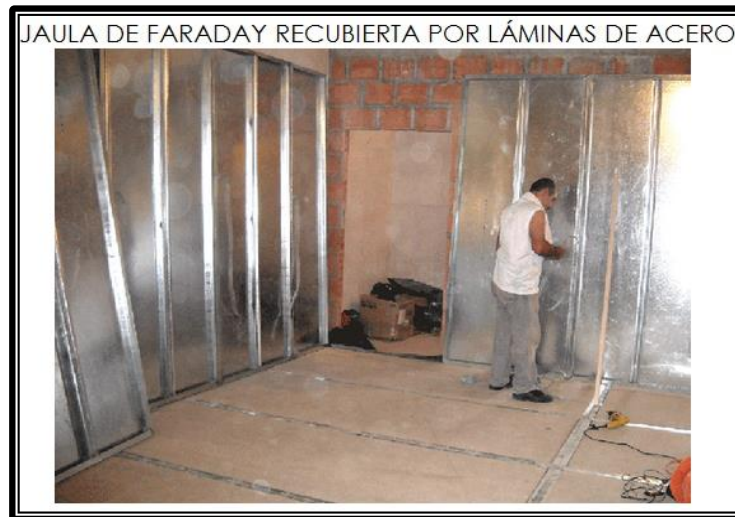
Figura 3.4. Láminas de acero utilizadas en la Jaula de Faraday.
