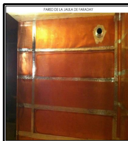
Figura 2.3. Pared construida para una Jaula de Faraday.
