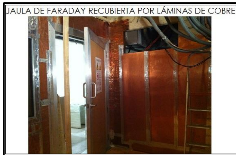
Figura 3.2. Láminas de cobre utilizadas en la Jaula de Faraday.
