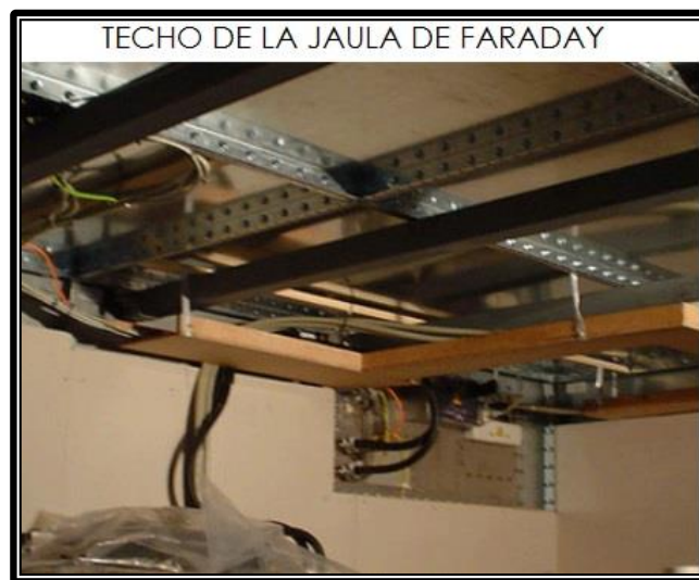
Figura 2.9. Techo construido para una Jaula de Faraday.
