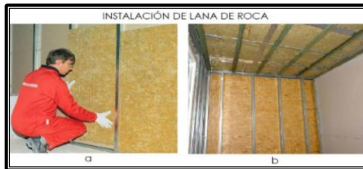
Figura 2.4. a. b. Instalación de lana de roca en una Jaula de Faraday.
