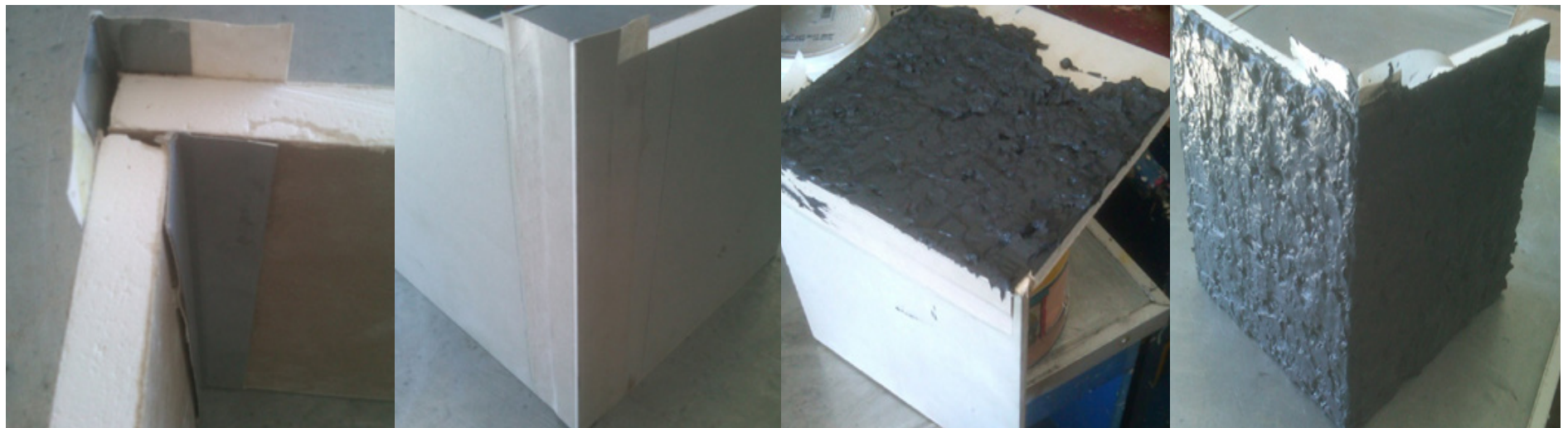
Instalación de los módulos utilizando los perfiles
