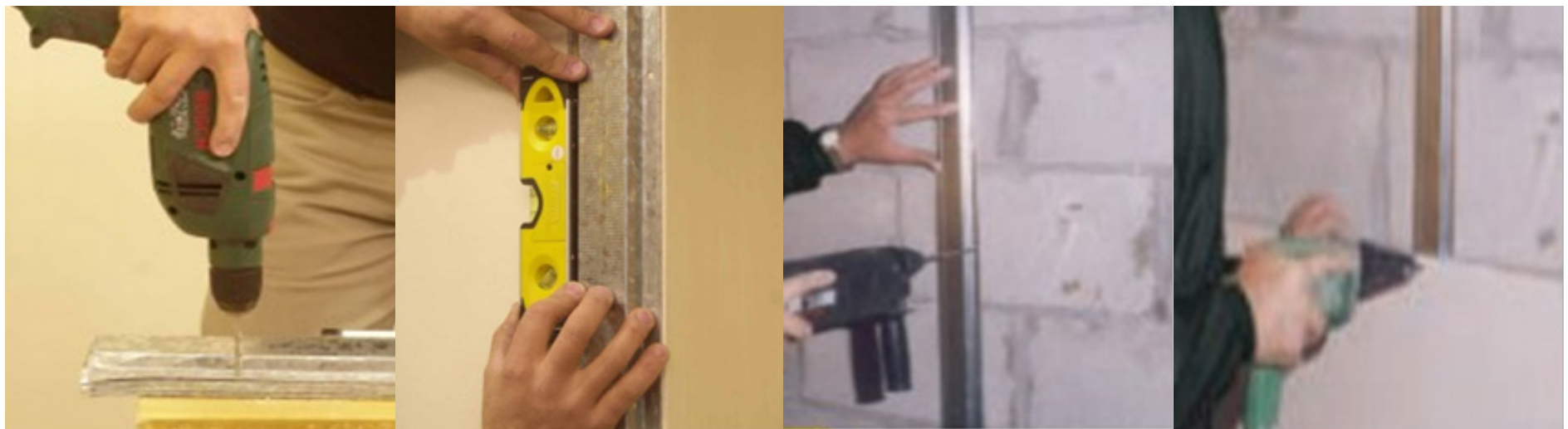
Instalación de los módulos utilizando los perfiles
