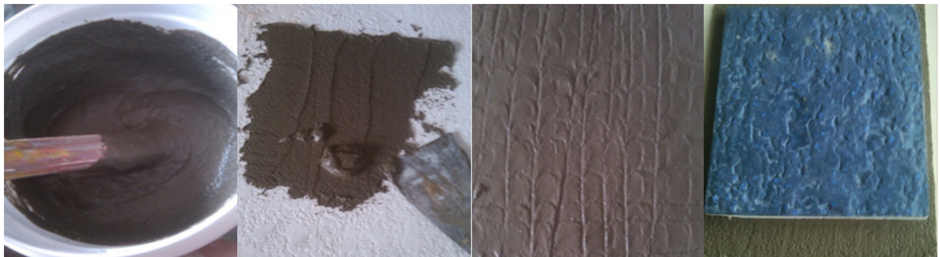
Instalación de los módulos aplicando mortero hidráulico a toda la superficie
