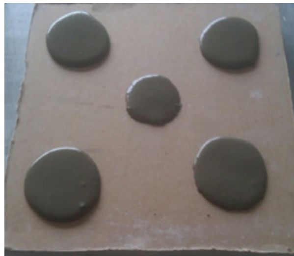
Instalación de los módulos aplicando mortero hidráulico en partes estratégicas del tablero
