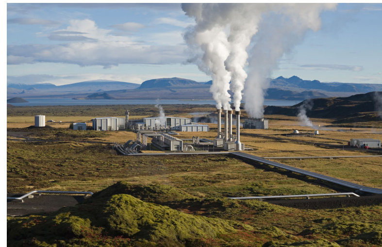
Energía Geotérmica http://upload.wikimedia.org/wikipedia/commons/2/21/Nesjavellir-PowerPlant.jpg
