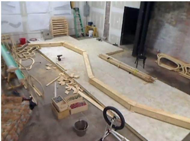
4. Realiza una estructura que se coloca en la base, esta estructura sirve como guía para la colocación de los perfiles y eleva el objeto para una mejor colocación de las tiras de madera en la base.
