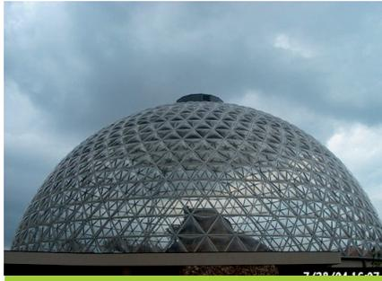
Fig. 7 Cúpula geodésica
