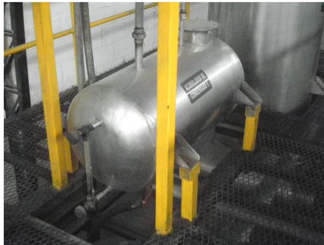
Figura 2.7. Acumulador de condensado.
