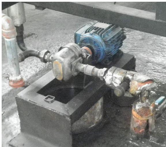
Figura 2.18. Bomba para clarificación de aceite.
