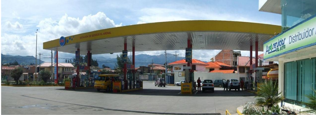
Gráfico 1. Vista Panorámica de la Estación de Servicio “El Arenal”
