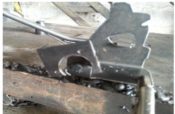
Soldadura de base del sensor.
