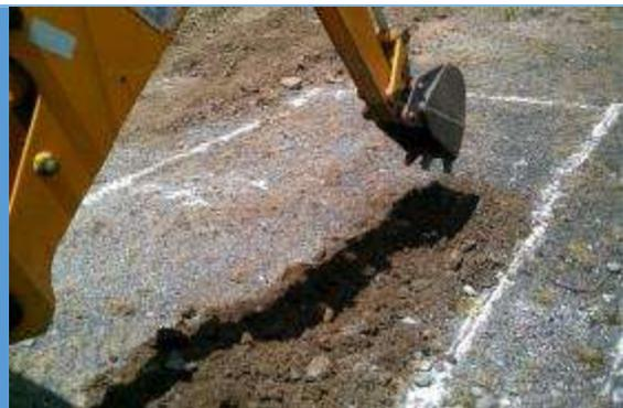
**Fotografía 4:** Vista del proceso de remoción de tierra, para la formación de las pozas de tratamiento.
